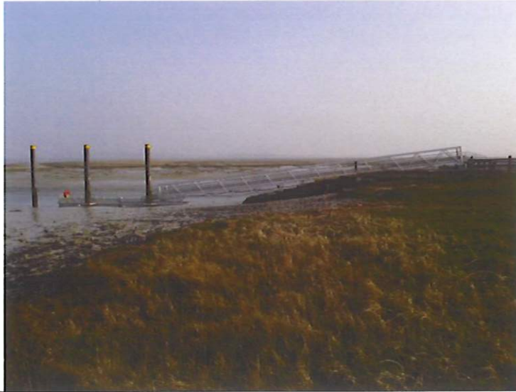
Le Hourdel, la passerelle (le phare se situe à droite) Photo jointe par le commissaire enquêteur
