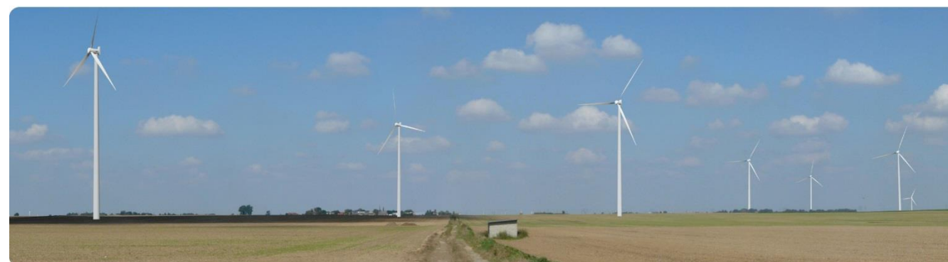
Photo 1 : Photomontage du projet éolien de Falvieux, prise de vue depuis le chemin agricole à Solente (source : ETD)
