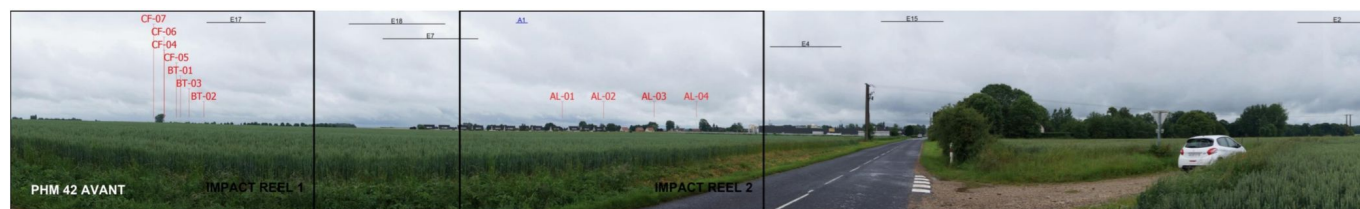
PM42 : RD21, entrée Nord d'Hallencourt
