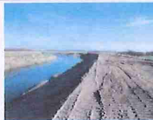
Figure 7 - Confortement localisé de berge en Baie de l'Authie (2011)
