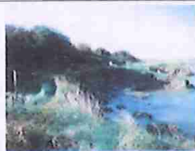
Figure 6 - Erosion de berge et digue fond de Baie d'Authie (2011)
