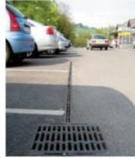
Figure 17 : Collecteur sous chaussée
