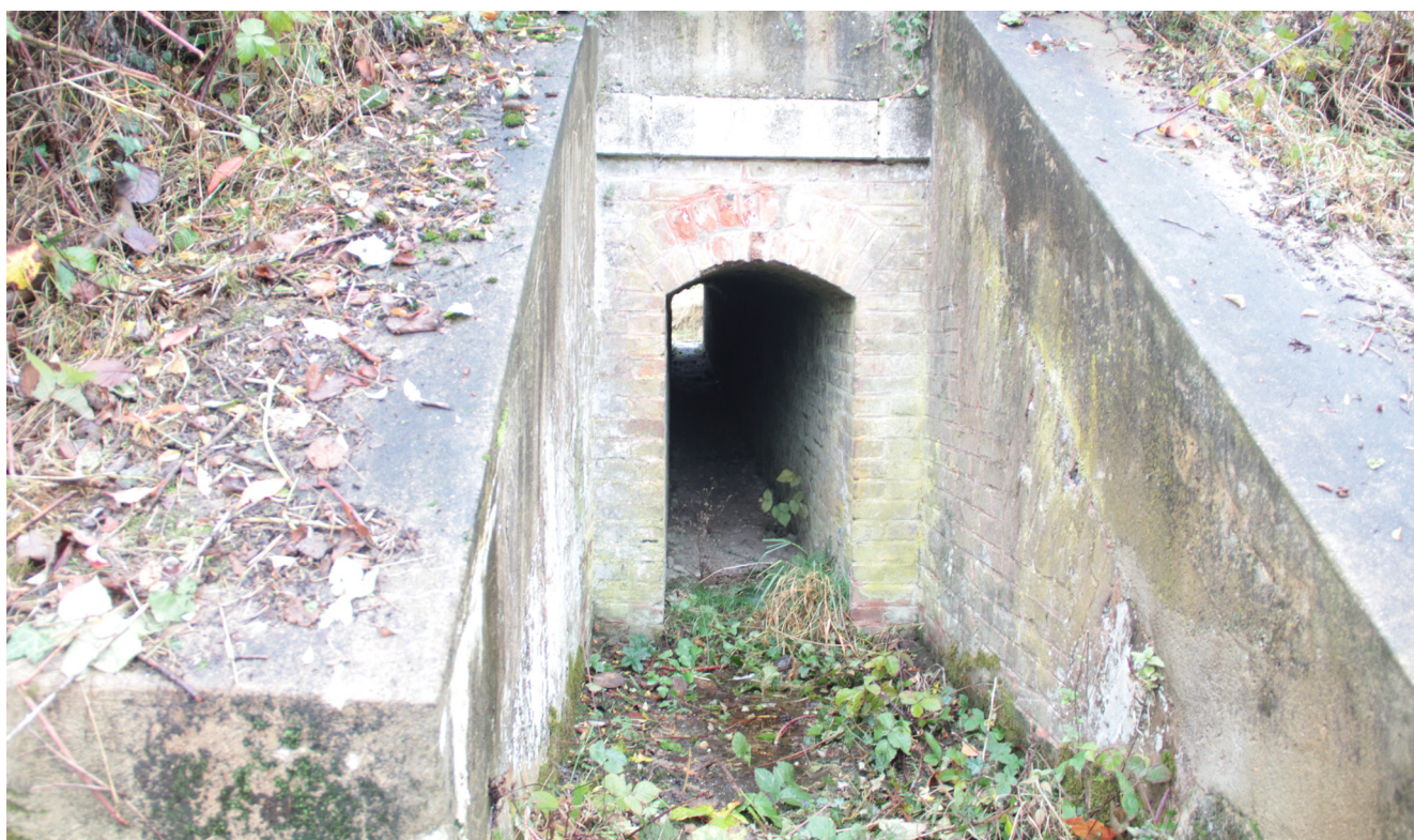
Photo 2 : Présence d'une buse en amont du site
