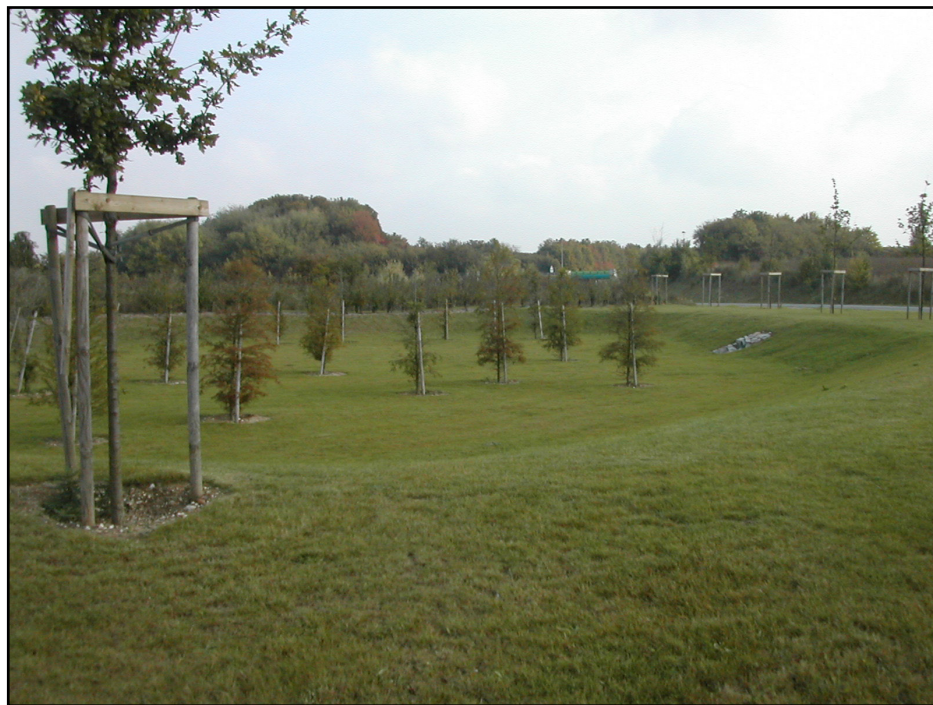
Photo 1 : Exemple d'un bassin d'infiltration
