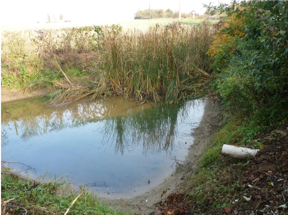
Bassin de rétention à l'ancienne gare de Candas
