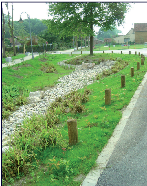
Photo 6 : Exemple de noue paysagère à Vaux-en-Amiénois
