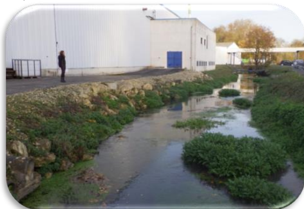
Illustration du tronçon B : enrochement présent en berge droite, berge érodée en berge gauche (Nov.2015, Ameva).
