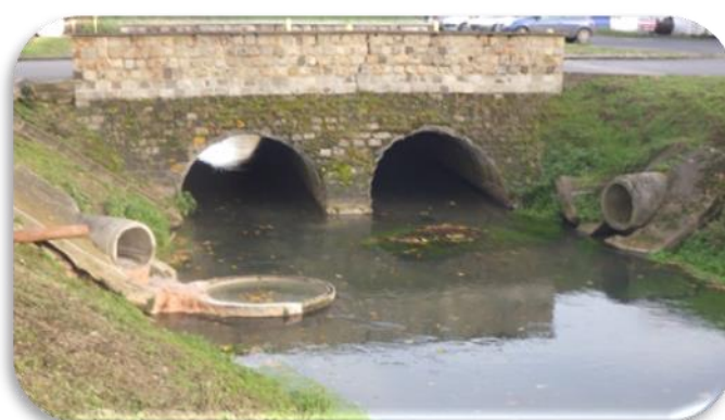
Illustration du tronçon D : à gauche, surlargeur du cours d'eau et à droite : rejets en amont du pont.
