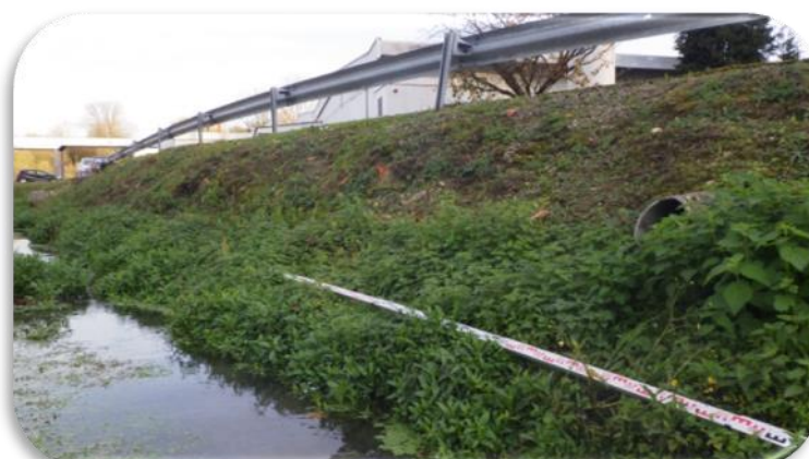
Illustration du tronçon B : enrochement présent en berge droite, berge érodée en berge gauche (Nov.2015, Ameva).
