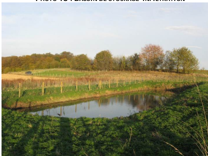
PHOTO 18 : BASSIN DE STOCKAGE-INFILTRATION
