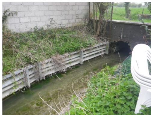
Palplanches métalliques en pied de berge du canal de Lanchères (à gauche) et glissières métalliques
