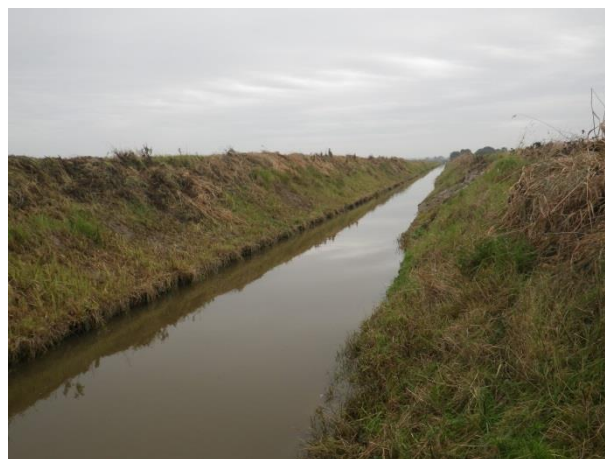
Berges abruptes du canal de Lanchères avec glissements (Octobre 2013, AMEVA).
