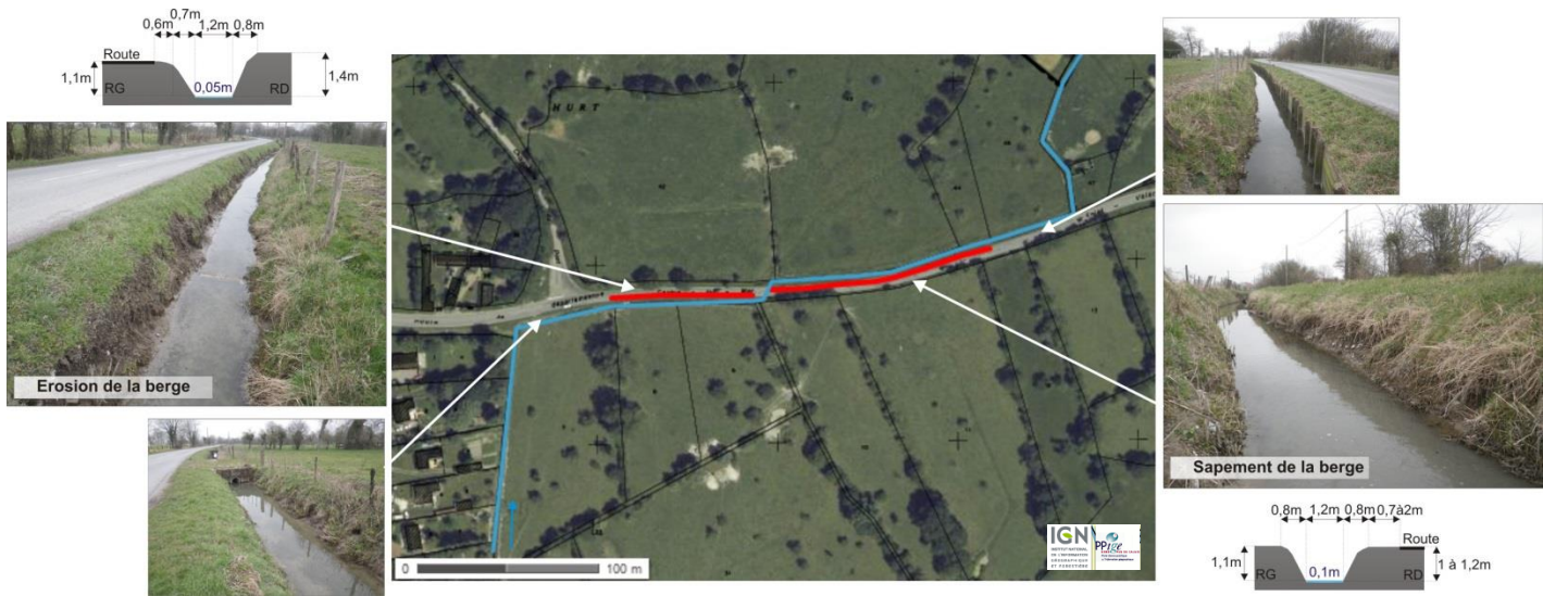
Eléments de diagnostic de la course du Gajolois au niveau de la RD 177 (AMEVA).
