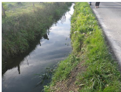
Berge fortement dégradée pouvant faire l'objet d'une protection à l'aide du génie végétal (à gauche) et accotement de la D177 à Hurt nécessitant une protection de type génie civil afin de stabiliser la berge le long de la route (à droite).
