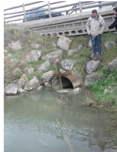
Vue amont de l'ouvrage (AMEVA).
