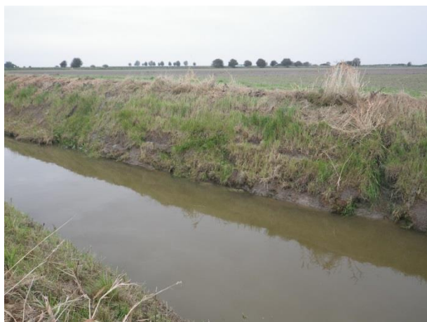
Berges abruptes du canal de Lanchères avec glissements (Octobre 2013, AMEVA).
