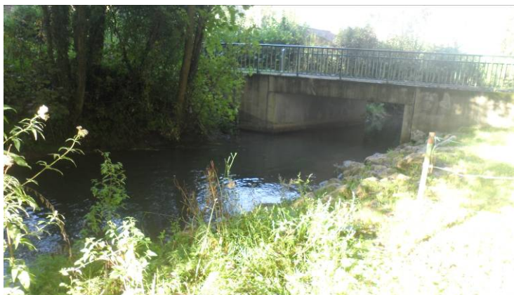
Figure n° 27: Pont de la D137 sur le canal d'Argoule
