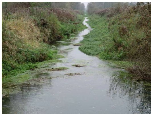
Digues bordant le Grand canal en aval de la Grande ventellerie
