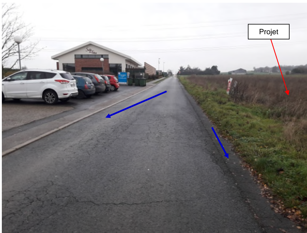
Photographie n°1 : Ecoulement des eaux pluviales rue de Beauquesne
