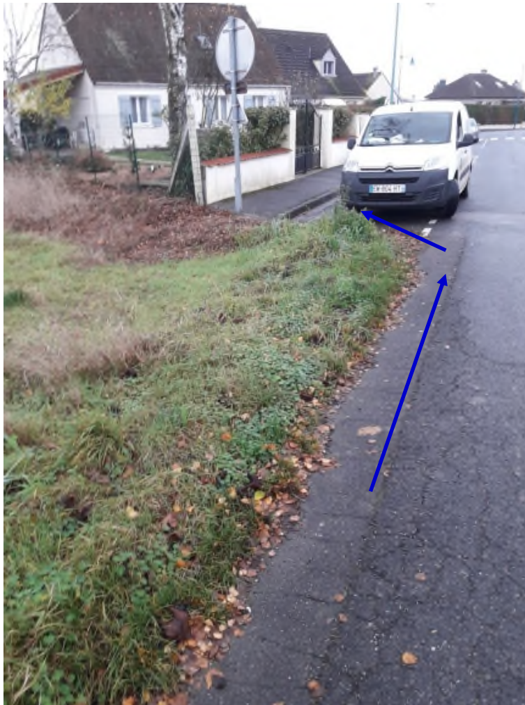
Photographie n°2 : Ecoulement des eaux pluviales rue de Beauquesne
