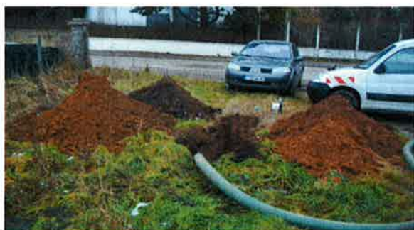
- Puits à la pelle mécanique EF2
