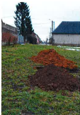
- Puits à la pelle mécanique EF1-1
