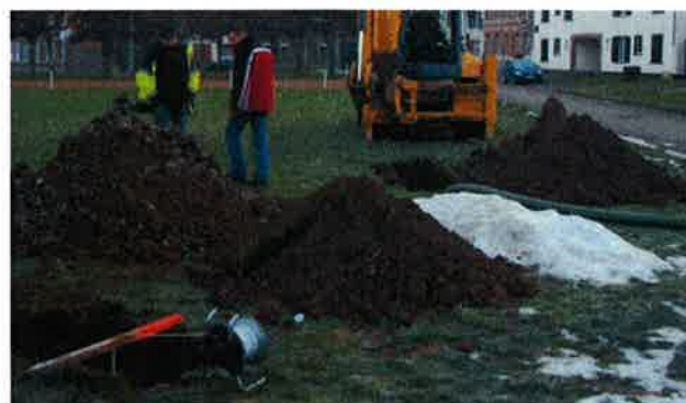
- Puits à la pelle mécanique EF3-1 et 3-2
