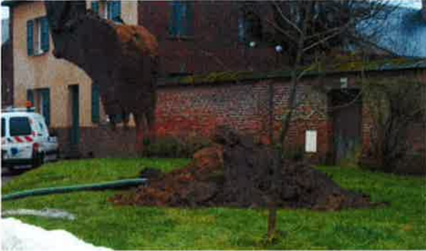
- Puits à la pelle mécanique EF6
