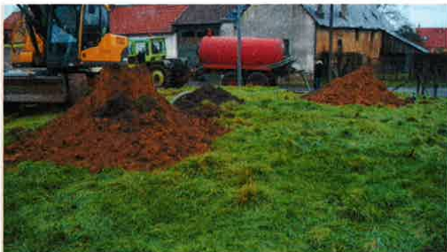
- Puits à la pelle mécanique EF8-1 et 8-2
