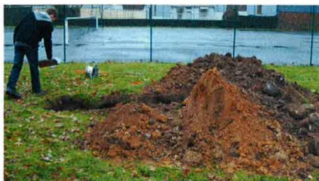
- Puits à la pelle mécanique EF5
