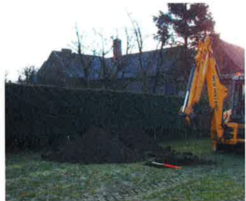
- Puits à la pelle mécanique EF9
