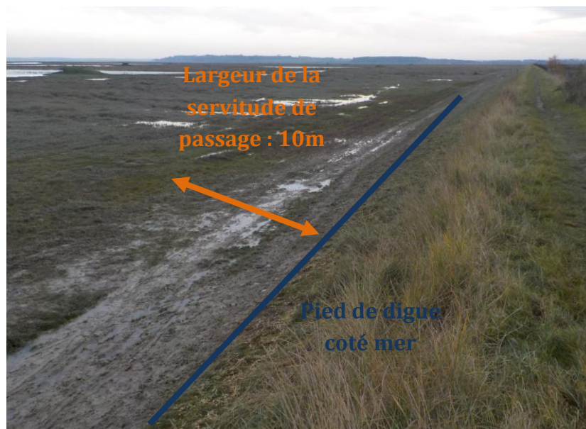
Figure 24 : Chemin existant en pied de digue côté mer (27/11/2018).
