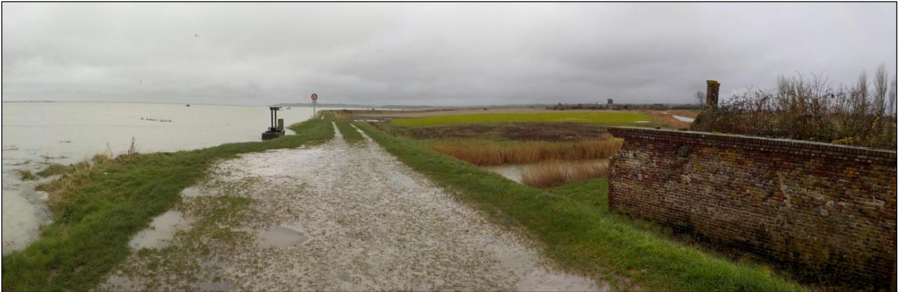
Figure 9 : Vue d'ensemble de la digue, de la porte à flot et du Courant à Poisson lors d'une grande marée de coefficient 100 (09/02/2016)
