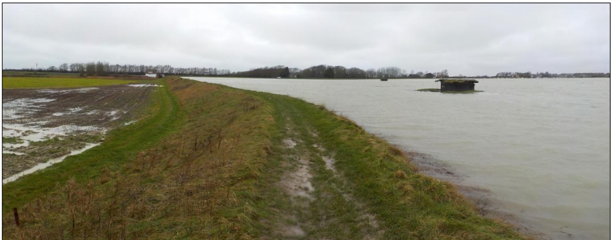
Figure 6 : Photographie de la digue de la Baie de Somme sud lors d'une grande marée de coefficient 100 (09/02/2016)
