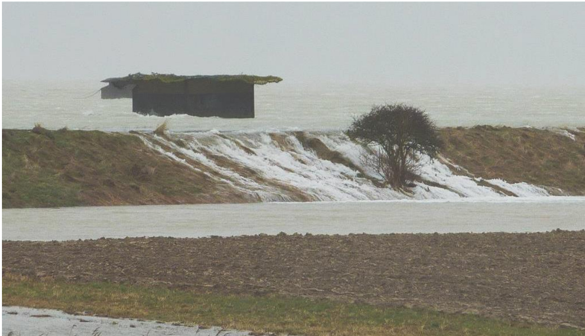
Figure 14 – Surverse de la digue de la Gaîté sur un point bas lors de la tempête Xynthia – 28/02/2010
