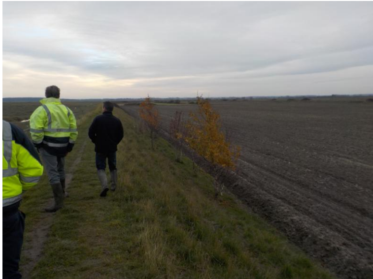
Figure 7 : Arbustes sur le parement interne, ID 103 (27/11/2018)
