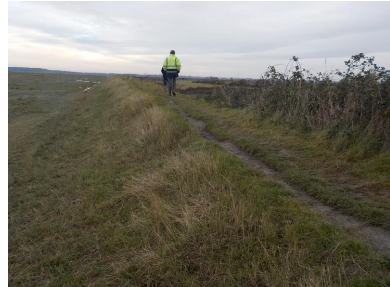
Figure 8 : Tassement de la crête et roncier sur le parement interne ID 104 (27/11/2018)
