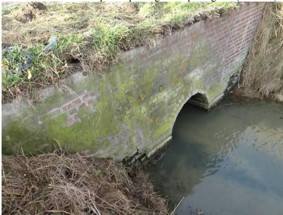
Figure 25 : Canalisation en brique voutée permettant l'accès à l'estran depuis l'accès #2
