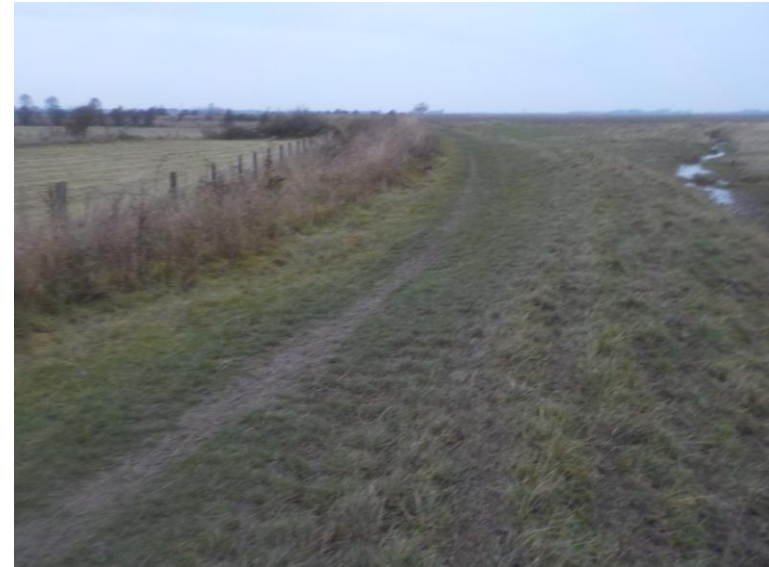
Figure 20 : Crête irrégulière et présence de ronciers sur le parement interne ID 62, 117 (27/01/2018)
