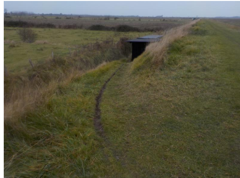
Figure 16 : Cabanon et accès sur le parement interne, ID 50, 51 (27/11/2018)
