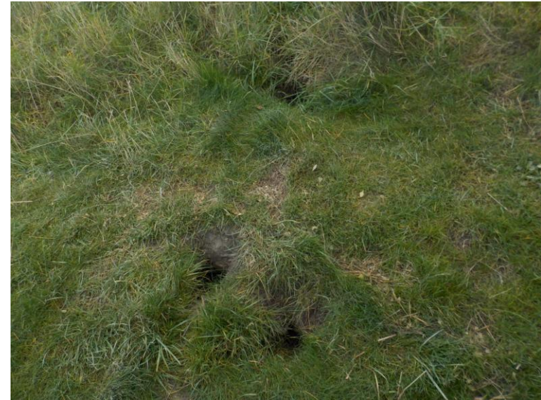
Figure 4 : Terriers dans le parement externe ID 1 (27/11/2018)
