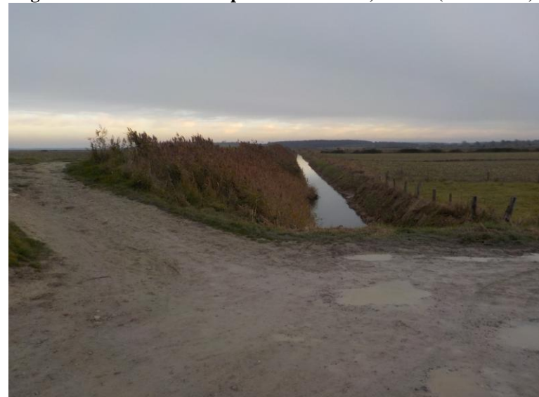
Figure 14 : Tassement dû au passage de véhicules sur le parement interne et la crête, ID 34 (27/11/2018)
