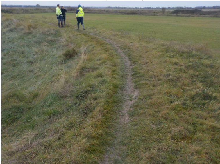
Figure 9 : Léger tassement de la crête par le cheminement sur le sentier du littoral ID 108 (27/11/2018)
