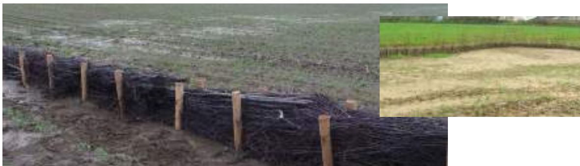
Photo 8 : fascine en plein champ (encart : dépôt sédiment au droit d'une fascine)
