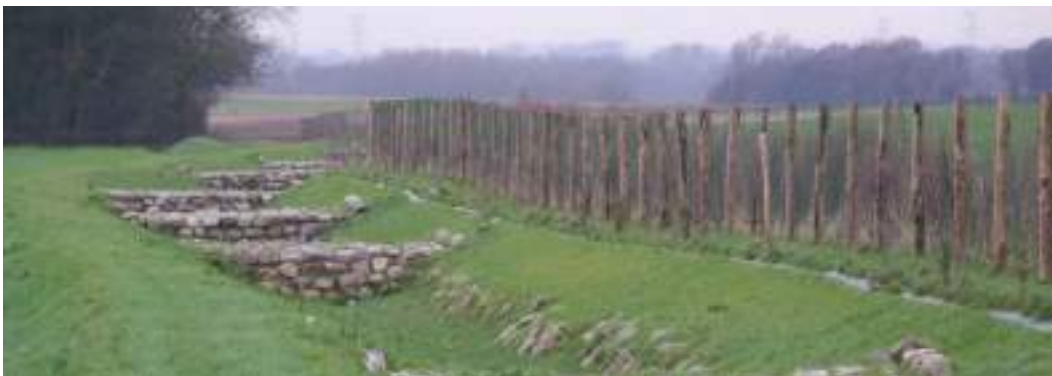
Photo 17 : seuils par enrochement
