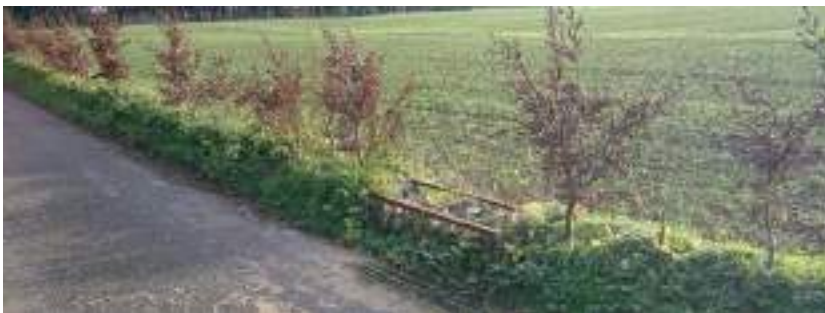
Photo 13 : exemple d'un petit merlon planté d'une haie avec débit de fuite aménagé (gabion)
