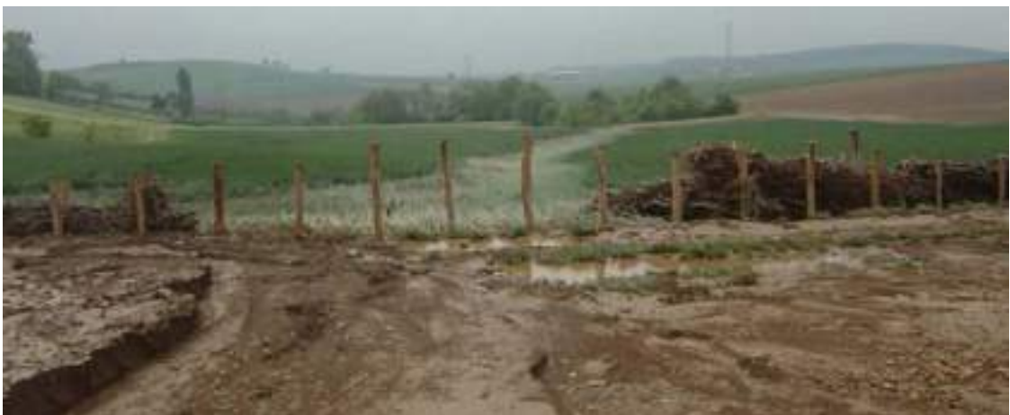
Photo 10 : rupture de fascine par pression hydraulique d'un ruissellement concentré à fort débit
