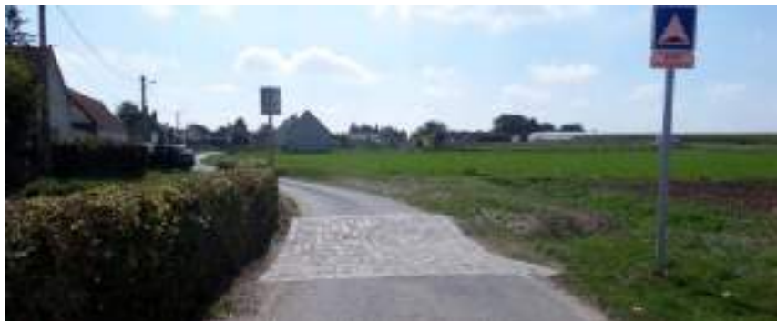
Photo 14 : exemple de passage à gué pour trop-plein d'une mare (à gauche)
