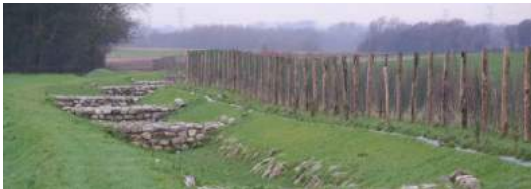
Photo 17 : seuils par enrochement
