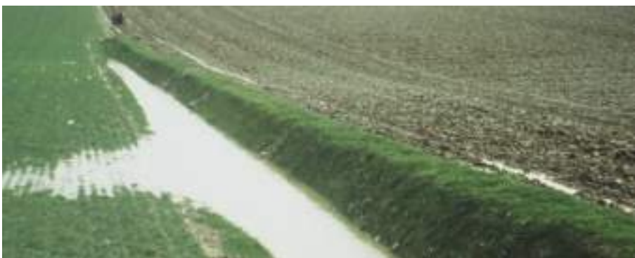
Photo 20 : exemple d'ouvrage en plein champ
