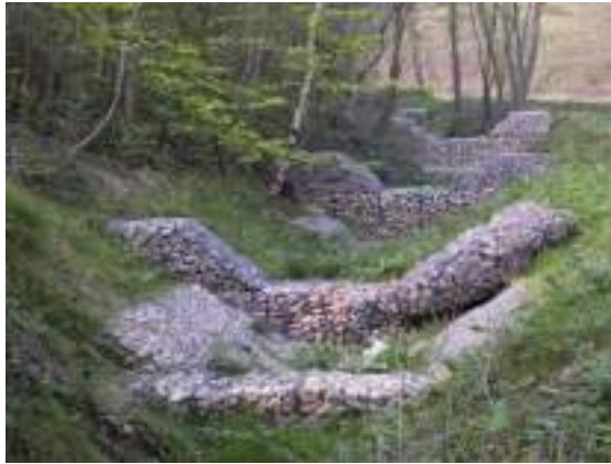
Seuils en gabion
