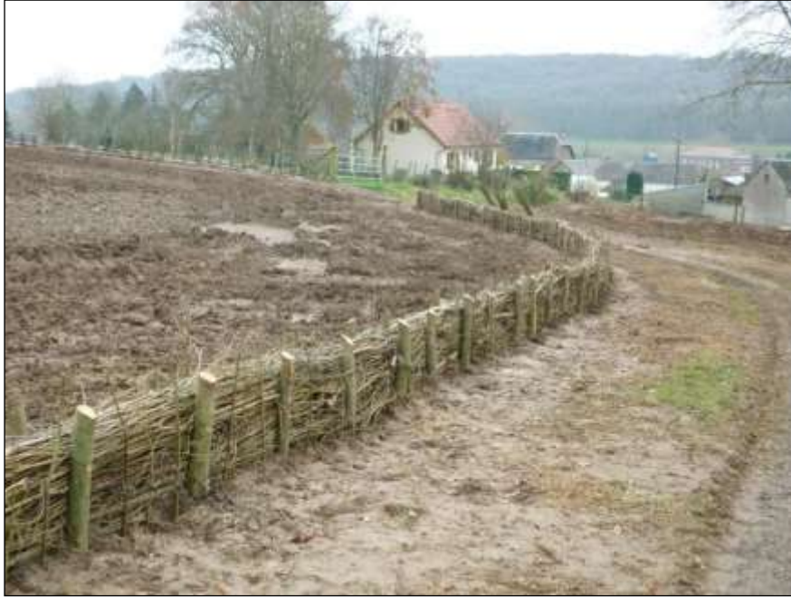
Photo 8 - Fascine achevée (Source : SOMEA)
