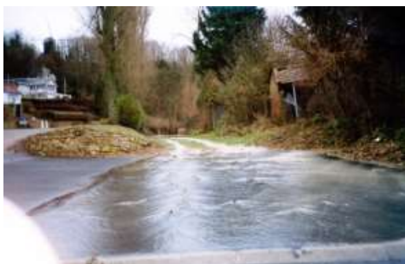
Photo 2 - Débordement de la Nièvre dans les rues de Naours
