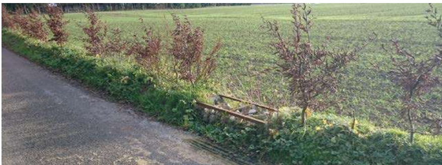
Exemple d'une diguette végétalisée avec un débit de fuite aménagé
