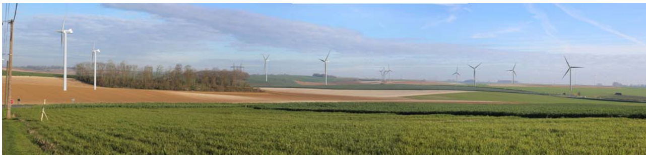
Organisation d'un projet éolien qui semble "anarchique"
