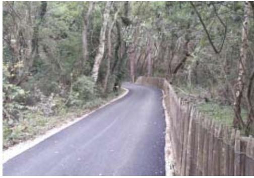
Après travaux – réfection de la piste
