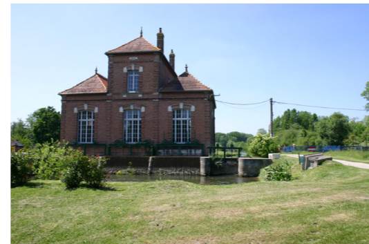
Fig.128. Usine hydroélectrique de Long
