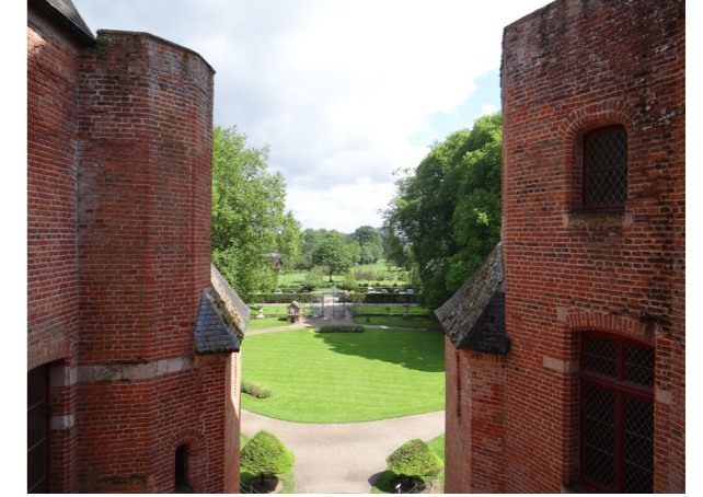
Fig. 104. Vue vers le Nord sur la grille d'entrée du château depuis le chemin de ronde à l'étage du château.
