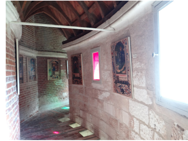
Fig. 103. Chemin de ronde à l'étage du château
