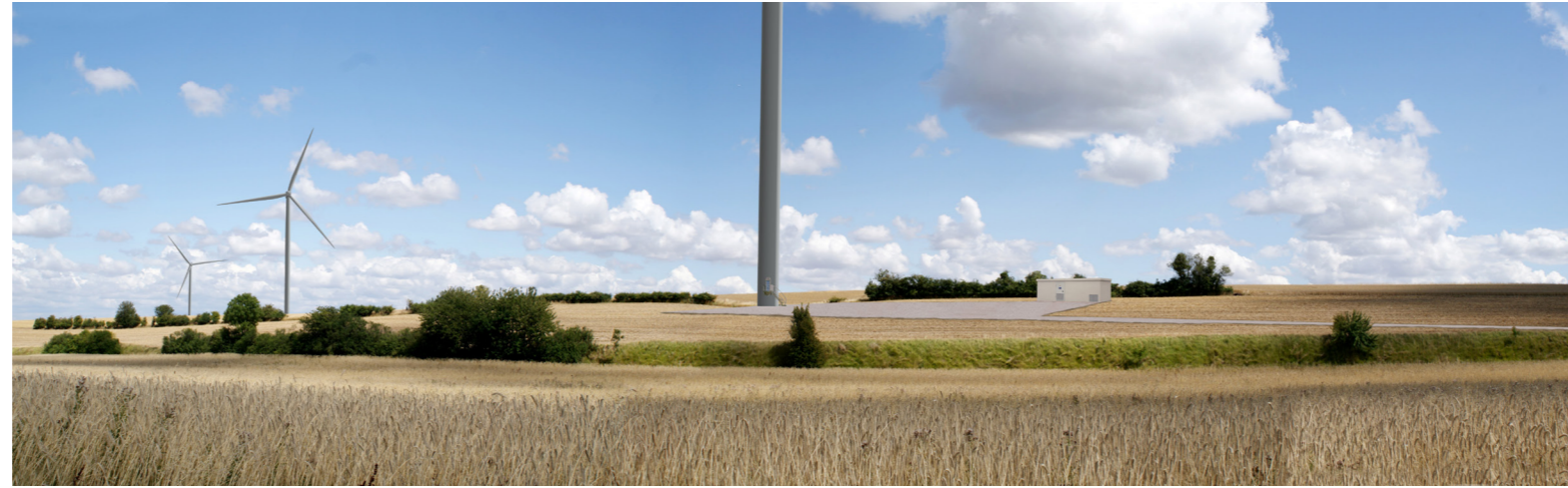
Photomontage du poste de livraison du parc éolien des Mottes (Source Ostwind)
