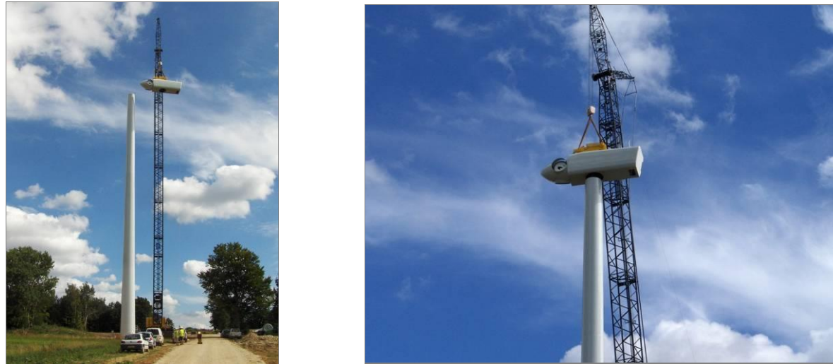
Figure 14 : Photos du chantier - assemblage de la nacelle
