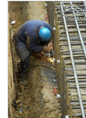
Préparation des fondations
