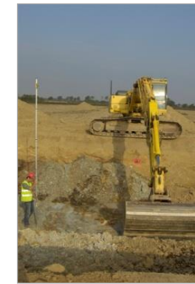
Fouille de la fondation
