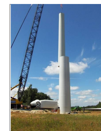
Figure 13 : Photos du chantier - assemblage de la tour
