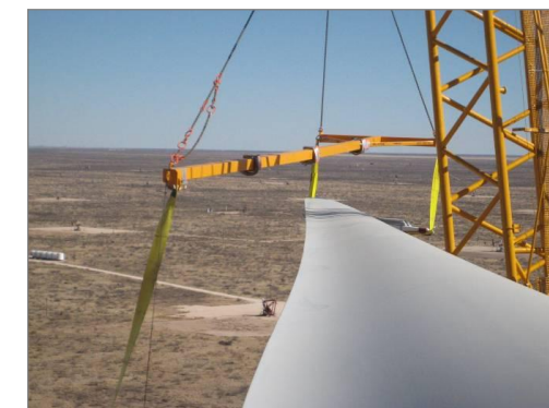
Figure 15 : Photos du chantier - assemblage des pales
