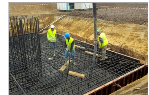
Coulage du béton
