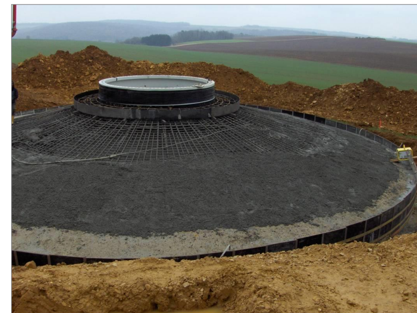
Figure 9 : Exemple de ferrailage en radier pour une éolienne (chantier en cours, source Vestas)
