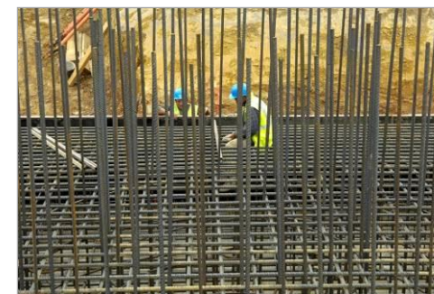
Ferrailage de la fondation
