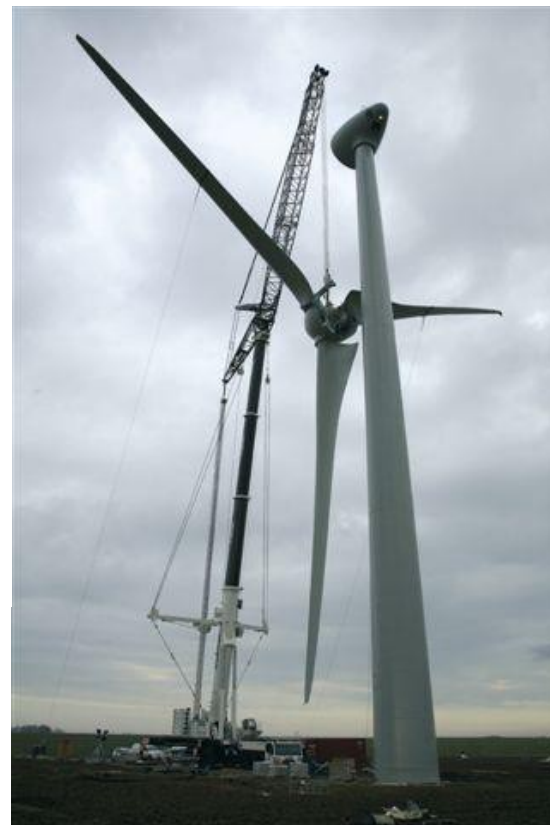
Figure 19: Assemblage d'une éolienne
