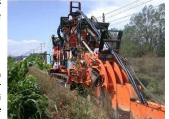
Engin utilisé pour le creusement de la tranchée sur environ 1 m de profondeur
