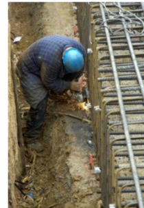
Préparation des fondations
