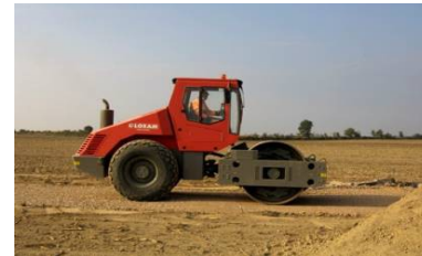
Aplanissement du terrain
