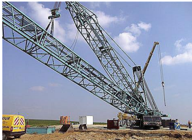
Figure 20: Grue de levage sur une plateforme
