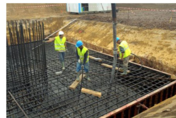
Coulage du béton
