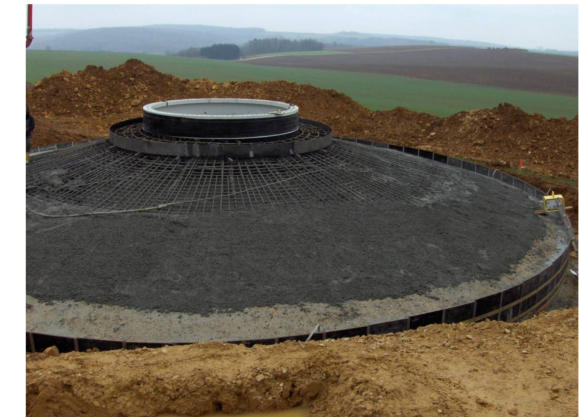
Figure 21: Exemple de ferrailage en radier pour une éolienne (chantier en cours)
