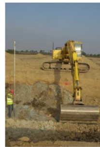
Fouille de la fondation
