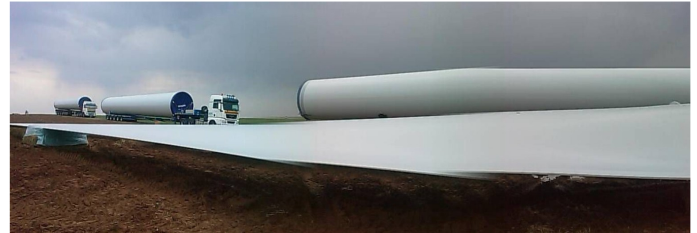
Exemple de stockage de pale
