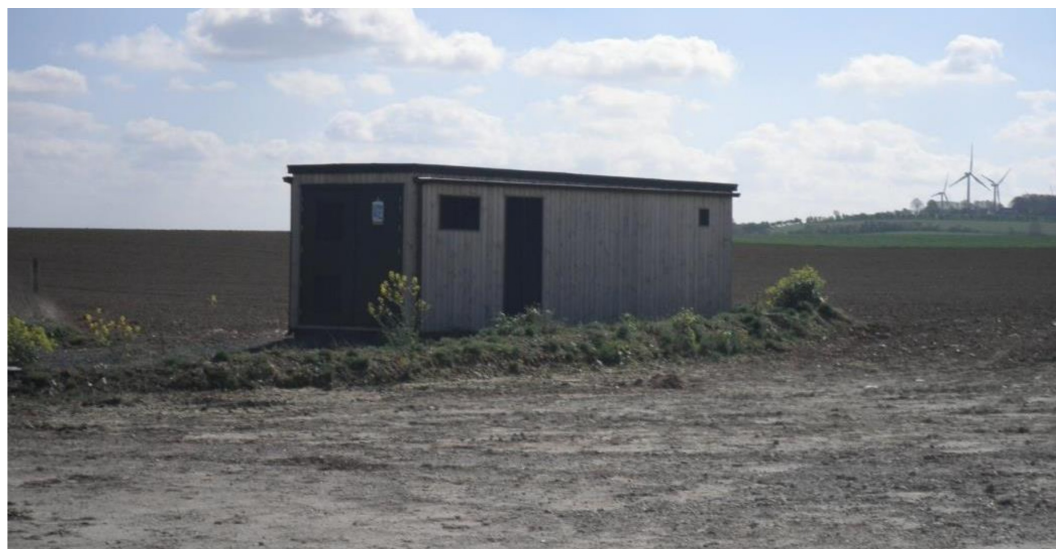
Figure 116: Poste de livraison envisagé
