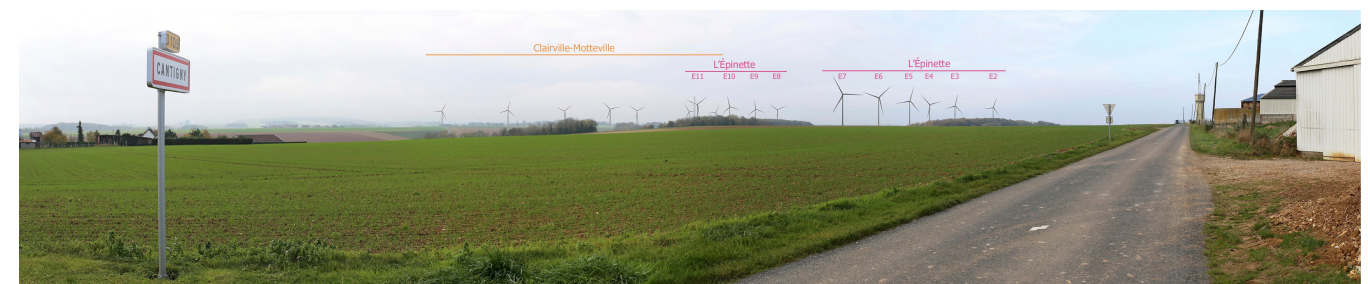
PM37- Depuis la sortie de Cantigny sur la RD109
