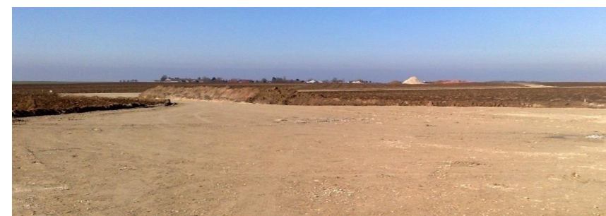
Figure 167 : Exemple d'aire de montage, grave compactée sur géotextile
