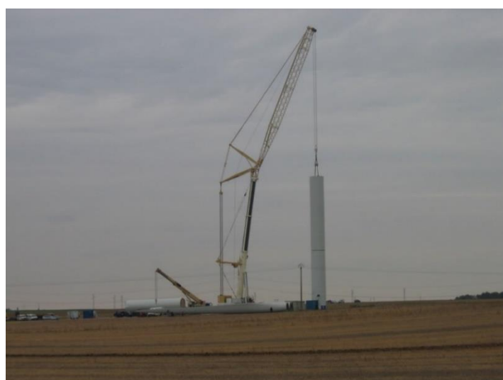
Figure 169 : Plate-forme en phase chantier
