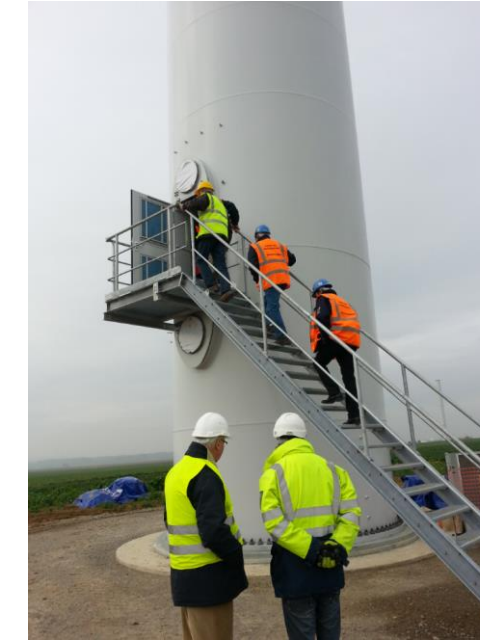
Figure 162 : Photographie de la base du mât NORDEX (Nordex, 2018)
