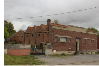
Photo129. Ancienne bonneterie d'Harbonnières (source : Base Mérimée)
