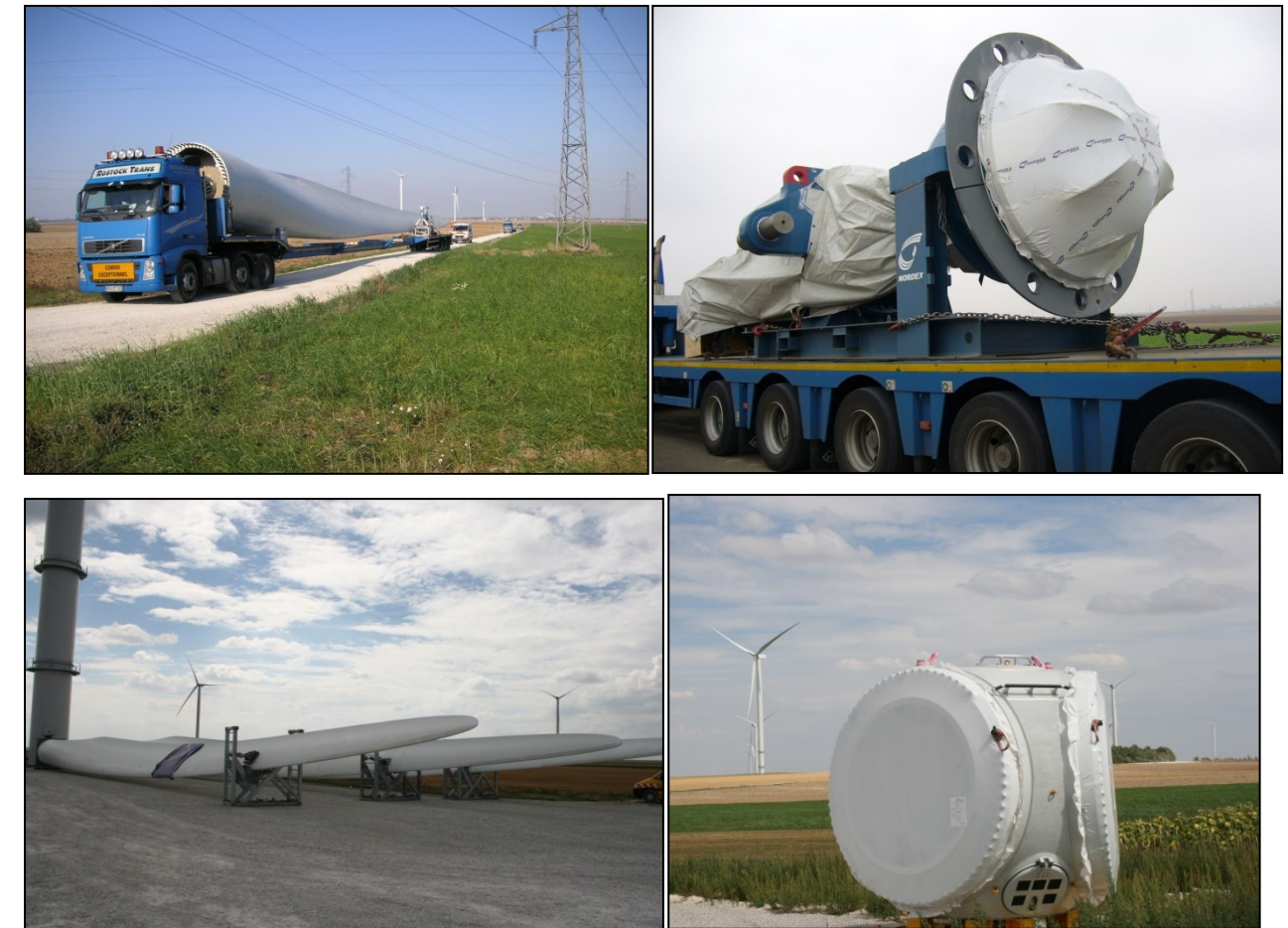
Figure 21 : Acheminement et stockage des éléments de l'éolienne
