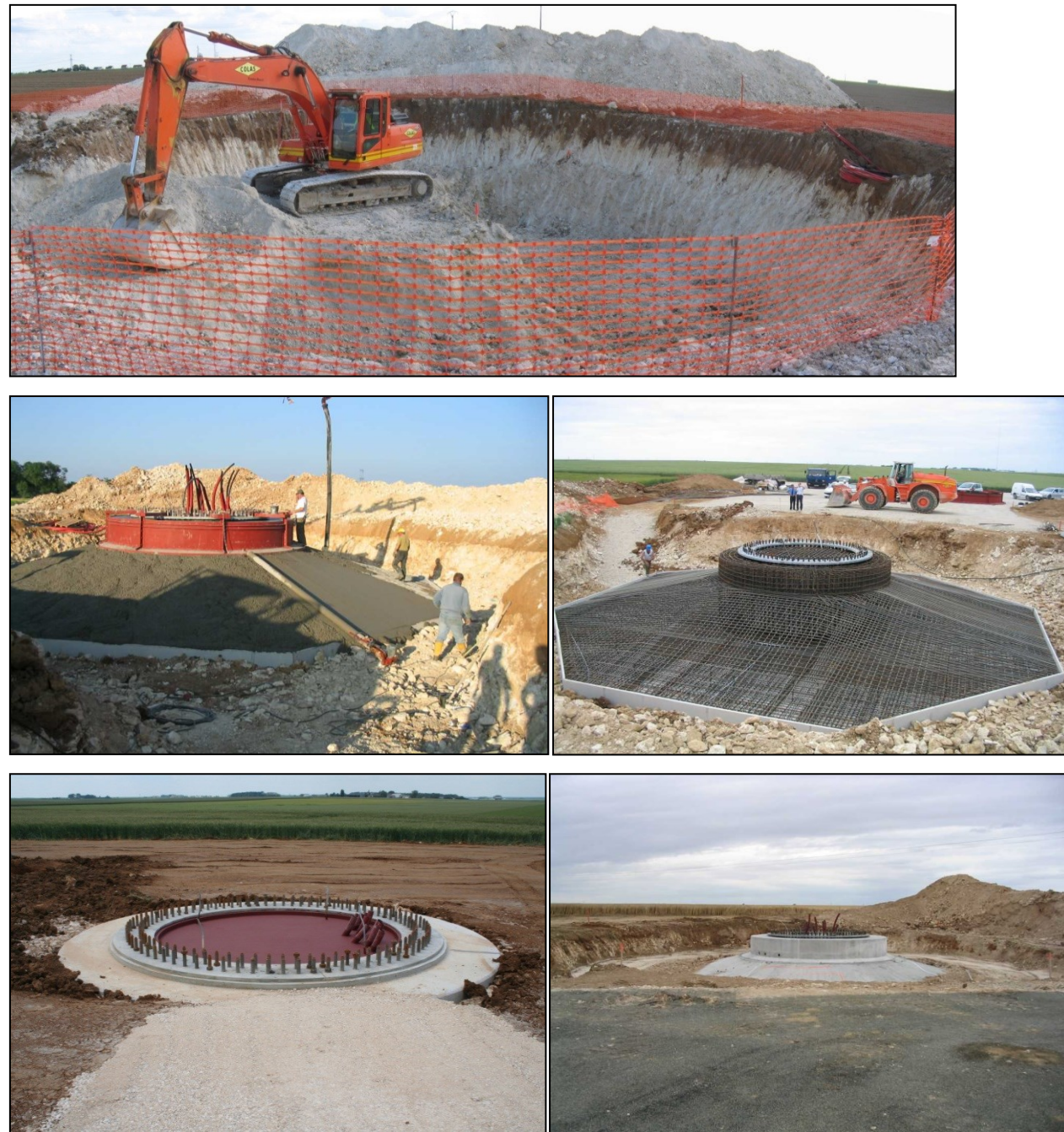
Figure 20 : Installation des fondations
