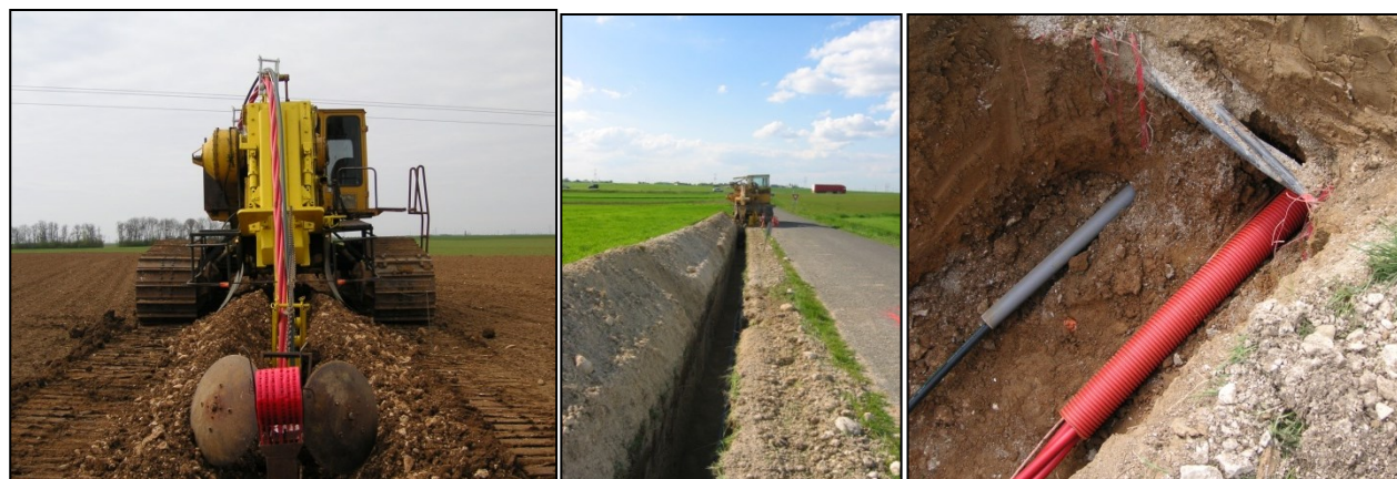
Figure 23 : Installation du raccordement électrique
