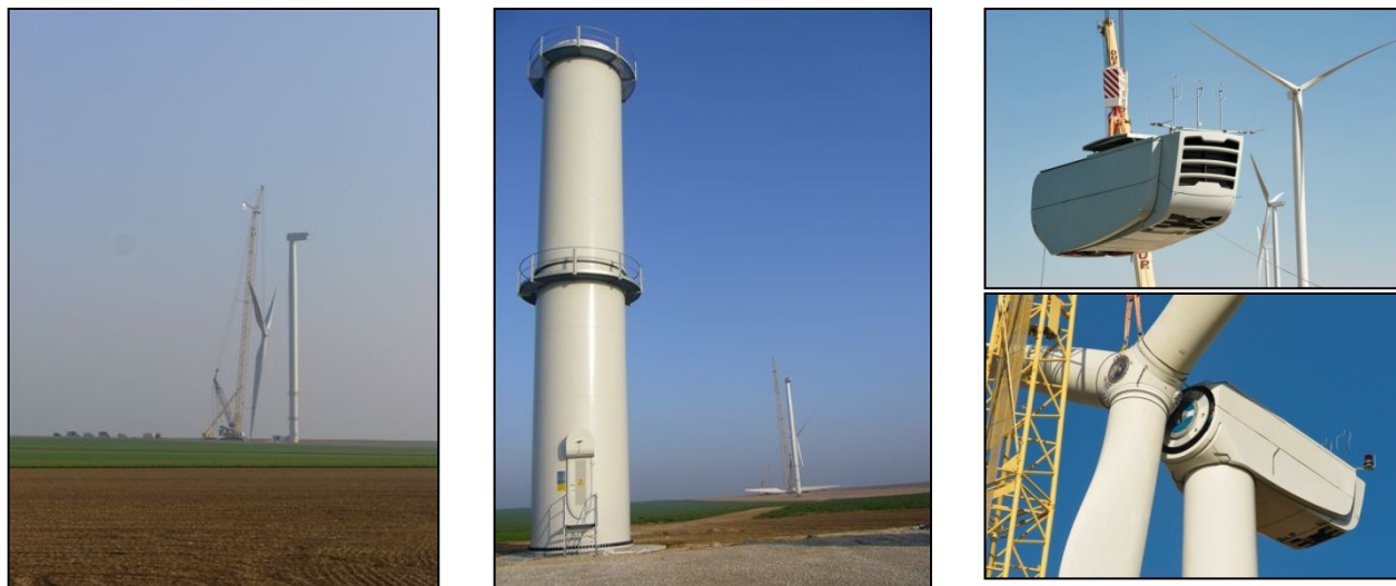
Figure 22 : Montage d'une éolienne
