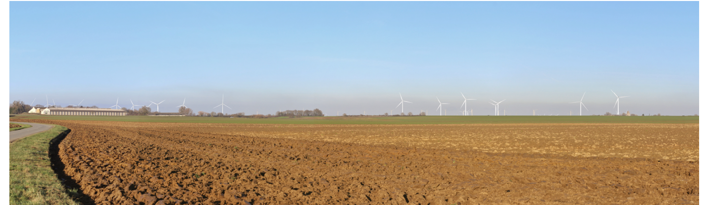
Figure 24 : Photomontage du Parc éolien des Althéas depuis la D68E au sud de Grivillers
