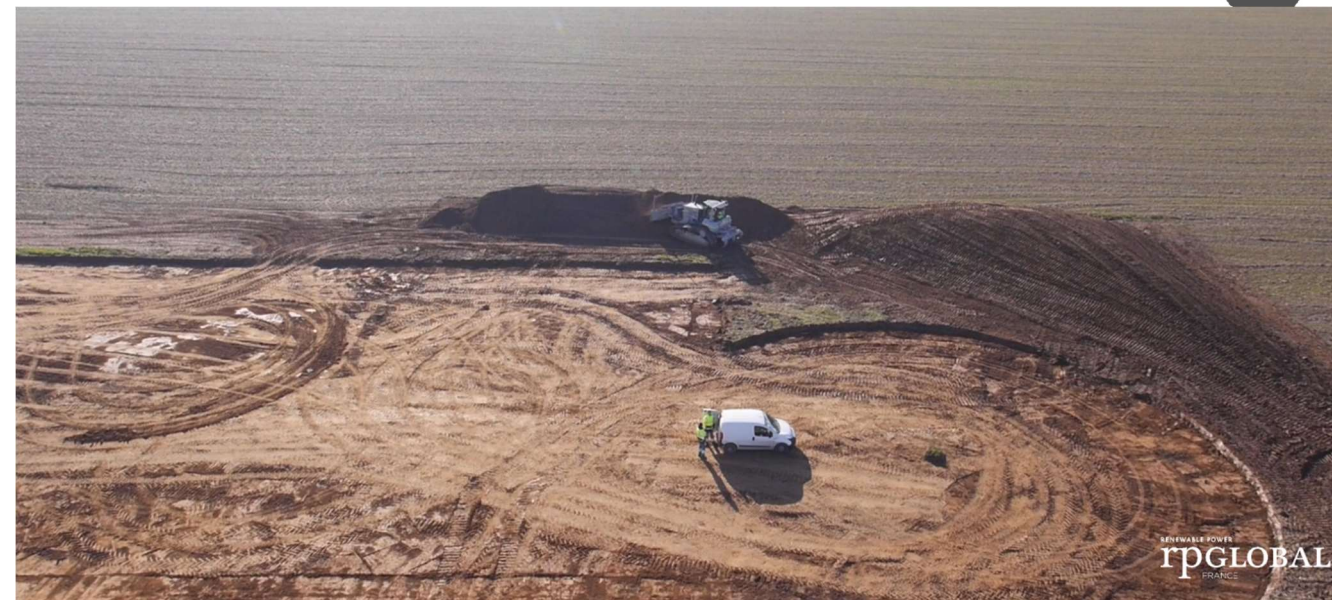
Figure 112 : Préparation du terrain
