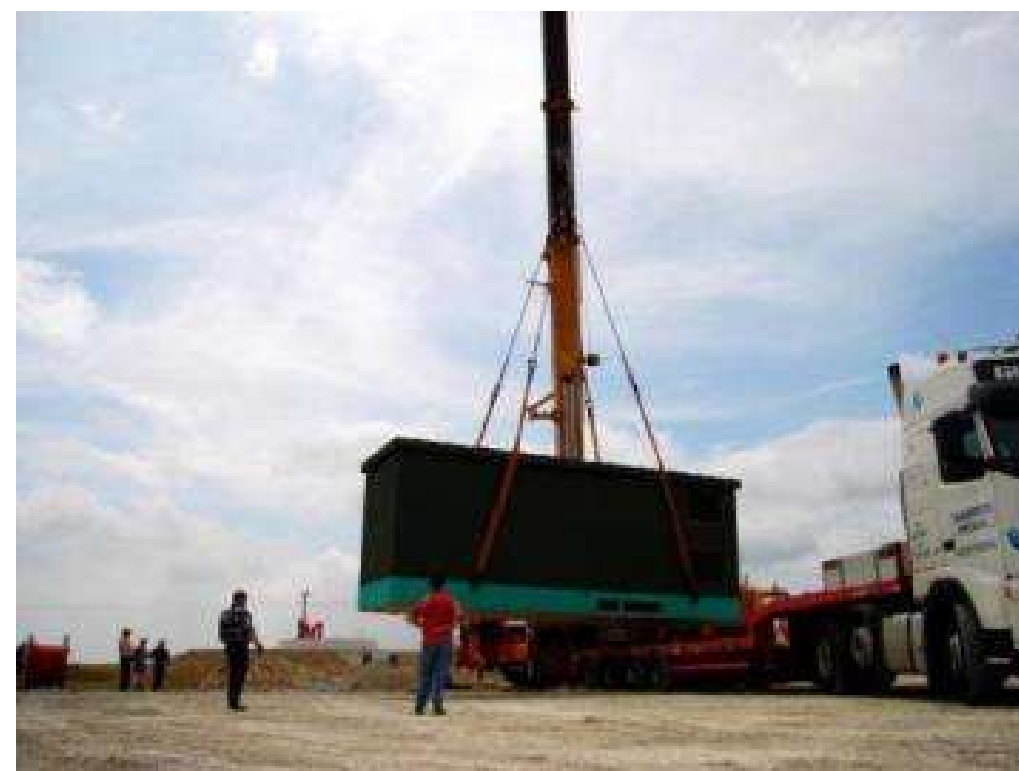
Figure 107 : Pose d'un poste de livraison
