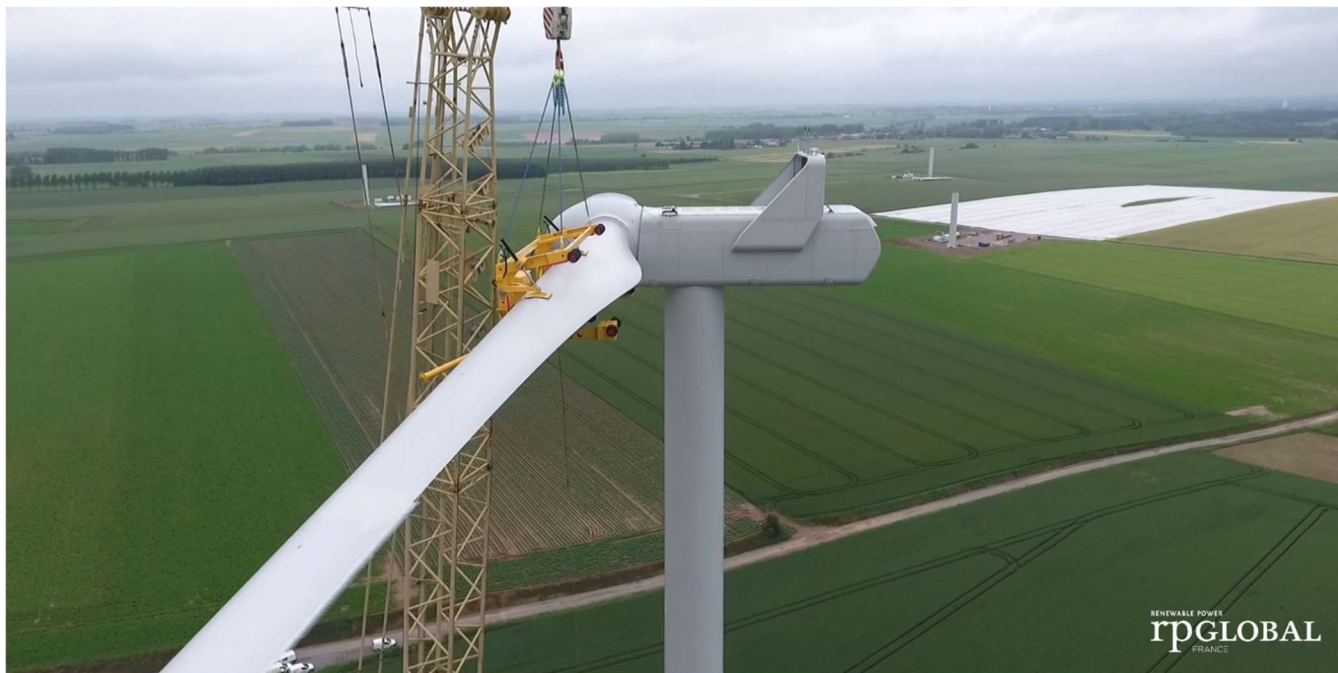
Figure 116 : Montage et assemblage des pales
