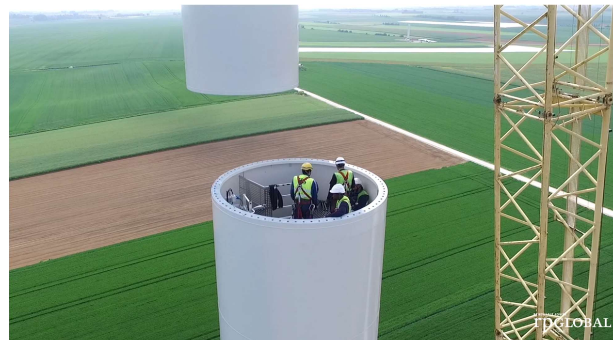
Figure 105 : Assemblage d'une section de tour
