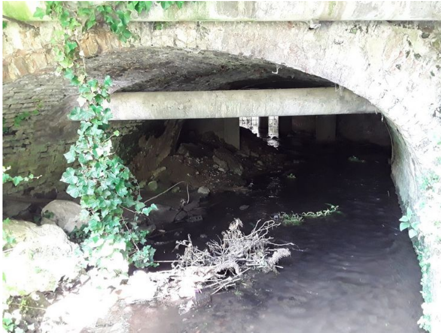
Figure 9 : Voûte d'entrée du deuxième passage couvert traversé par le fossé au droit du lycée
