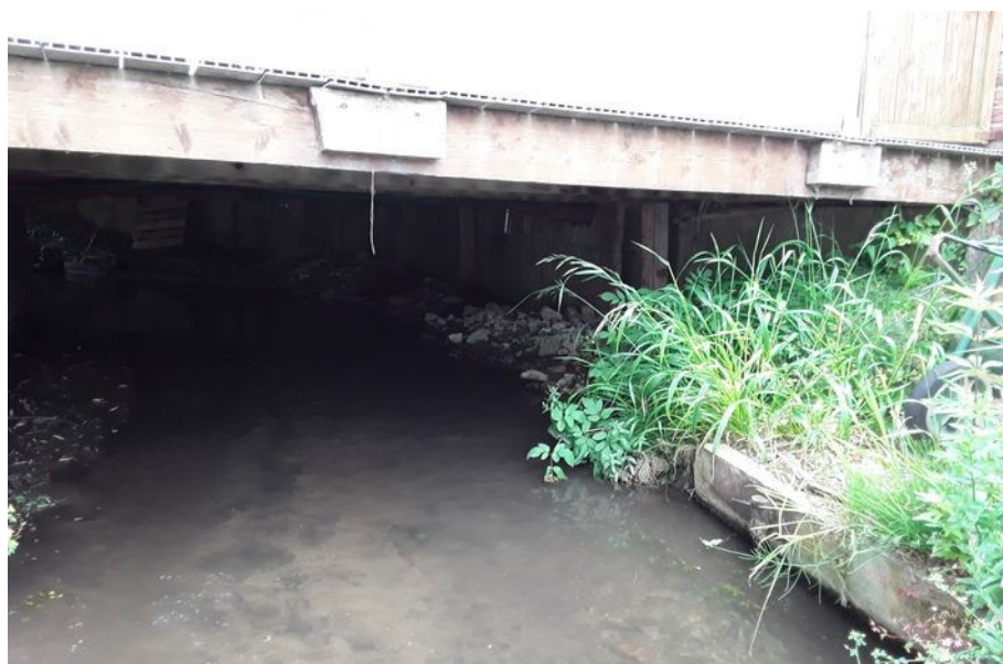
Figure 8 : Premier passage couvert traversé par le fossé au droit du lycée
