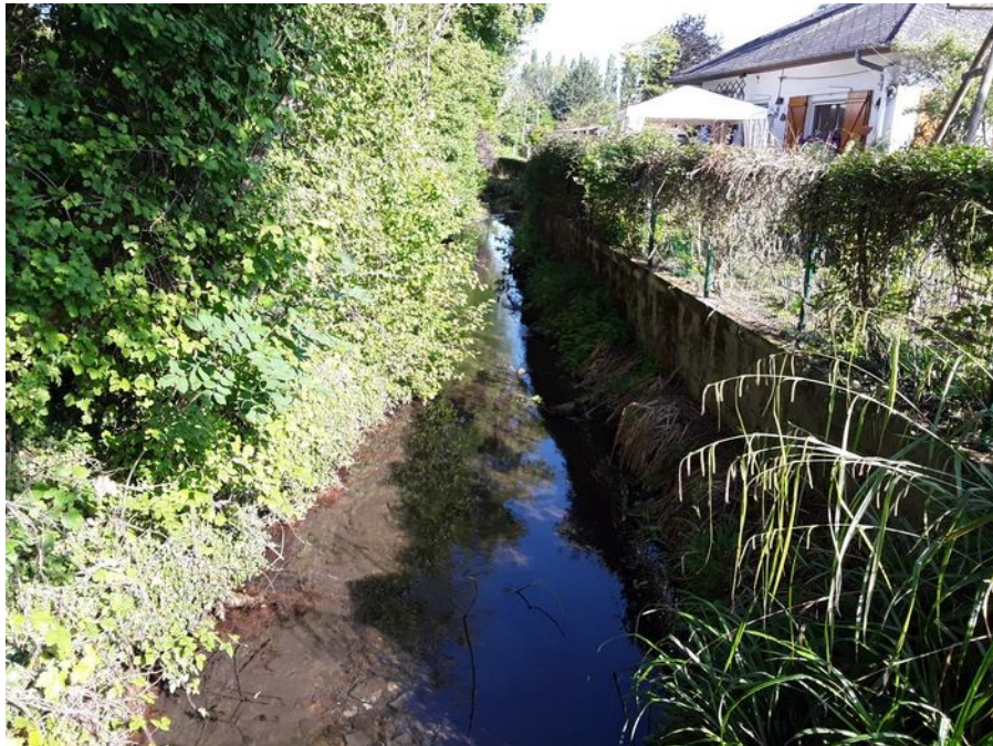
Figure 4 : Fossé Savignac à l'aval de la ruelle Saint-Sulpice
