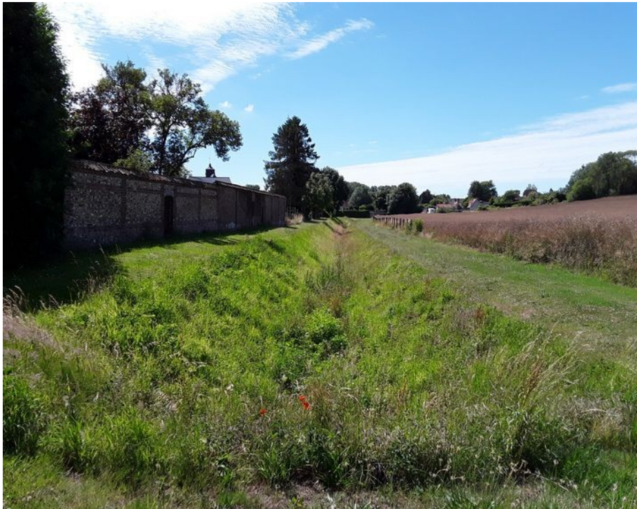
Figure 6: Fossé observé à l'aval de la rue du Château sur la commune de Vron
