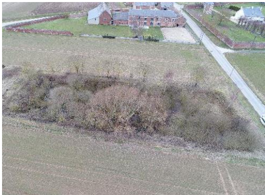
Illustration 3. Photos du bassin de rétention à débroussailler et curer (lieu dit du Lundi, sur Piennes Onvillers) (Crédit photo : SOMEA).
