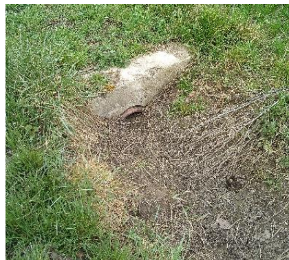
Illustration 4. Fossé à curer et buse à déboucher sur Assainvillers (Crédit photo : SOMEA)
