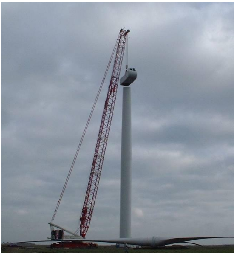
Photo 15 : Installation de la nacelle
