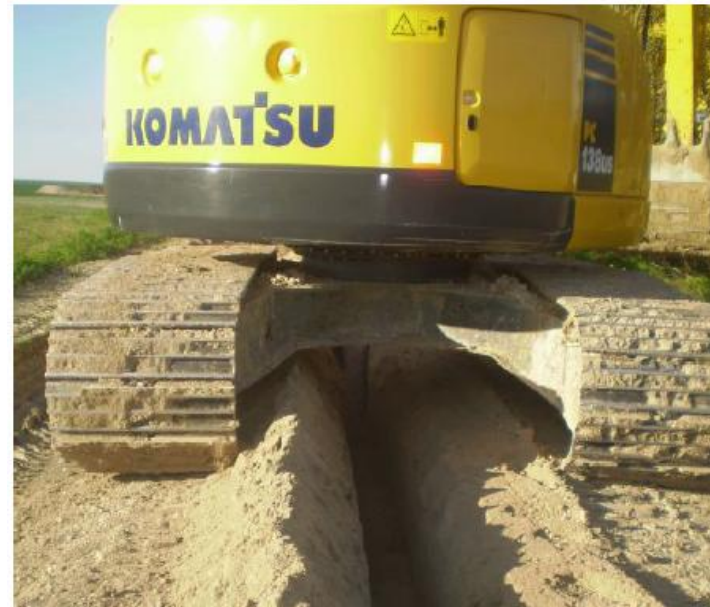
Photo 47 : Tranchée d'enfouissement des câbles électriques
