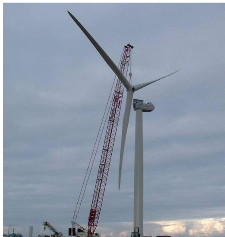
Photo 16 : Mise en place du rotor tripale
