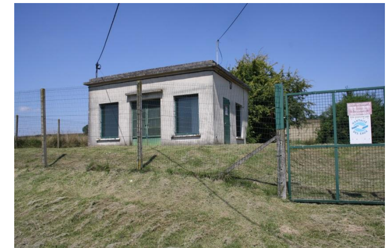
Photo 21 : Captage AEP de Berteaucourt-lès-Thennes
