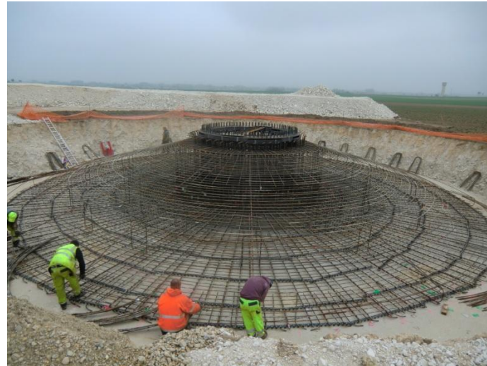
Photo 8 : Excavation et préparation de l'armature
