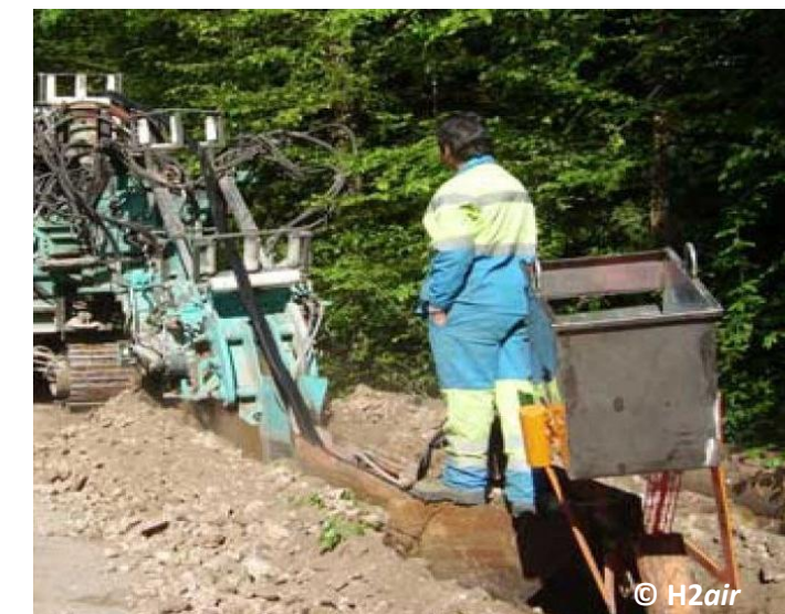
Photo 6 : Exemple de tranchées d'enfouissement du réseau électrique
