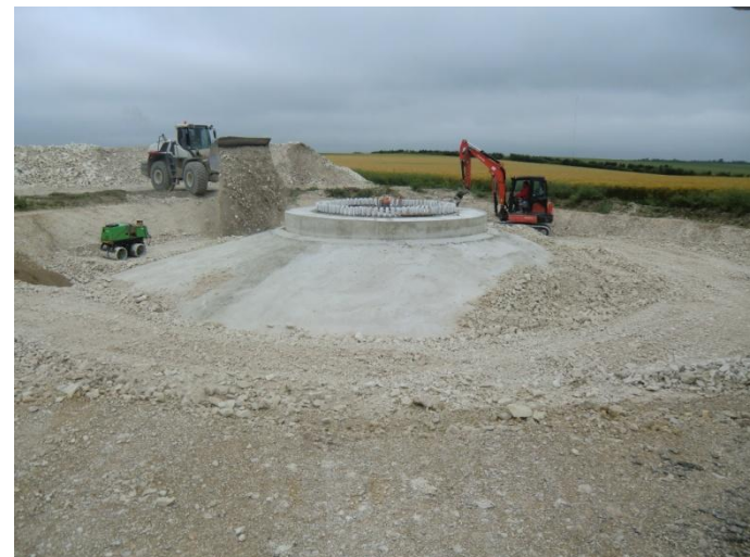
Photo 10 : Béton terminé et remblai
