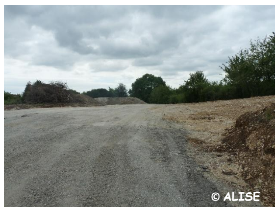
Photo 30 : Zone en travaux
