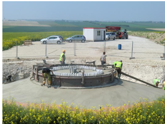
Photo 9 : Durcissement béton
