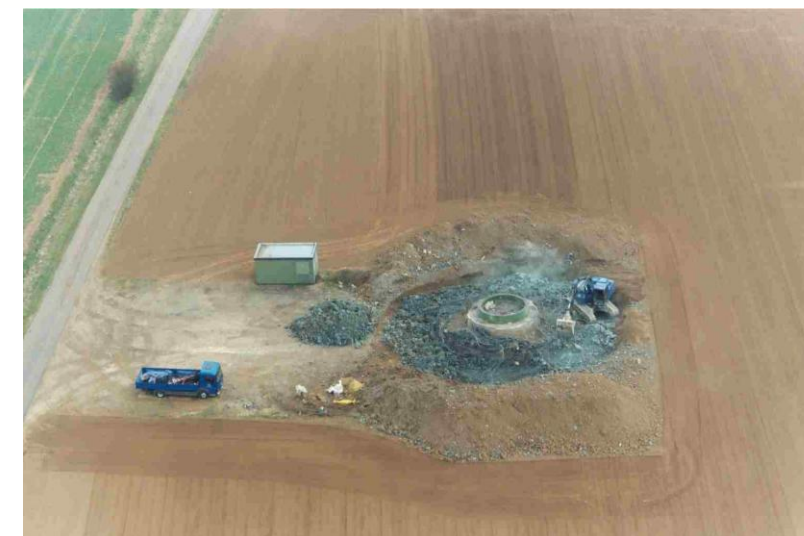
Photo 41 : Exemple de démontage de la plate-forme et des fondations d'une éolienne
