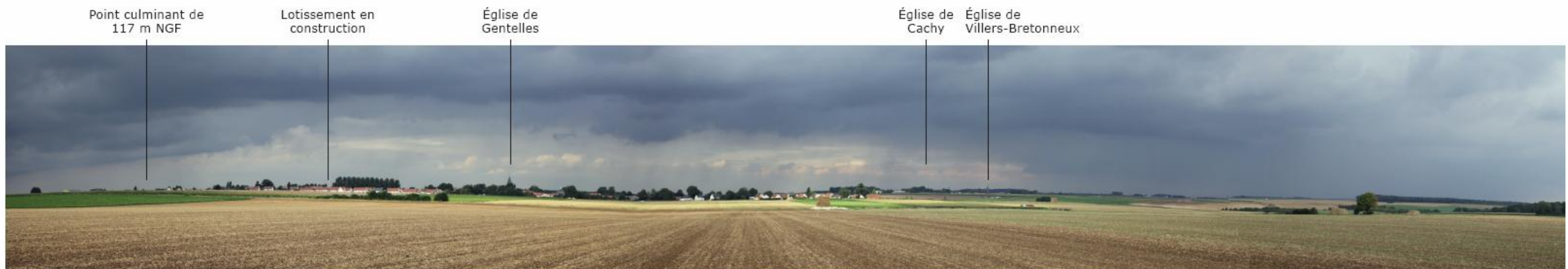
Figure 61 : Vue panoramique sur la partie nord de zone d'implantation potentielle depuis la RD 934
