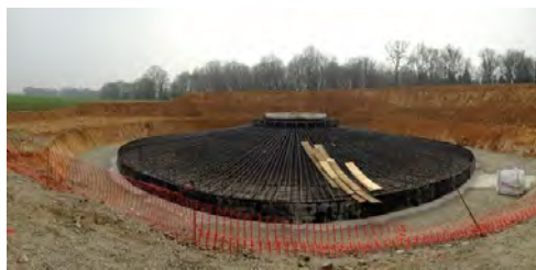
Ferrailage de la fondation
