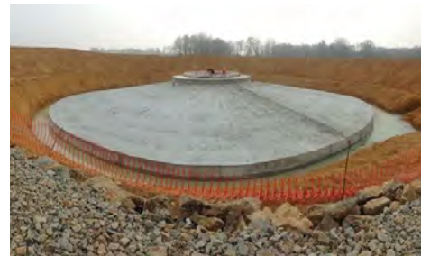
Fondation en séchage
