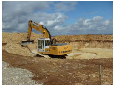
Fouille de la fondation
