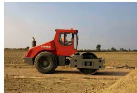
Figure 14. Compactage du terrain
