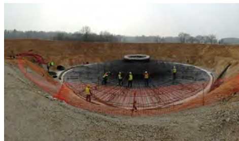
Préparation de la fondation
