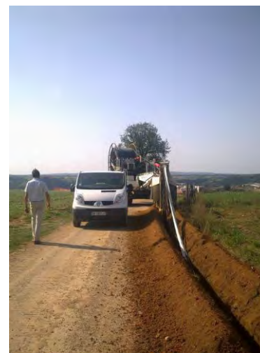
Figure 16. Creusement de la tranchée
