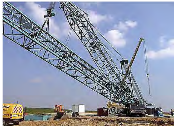
Figure 9. Grue de levage sur une plateforme
