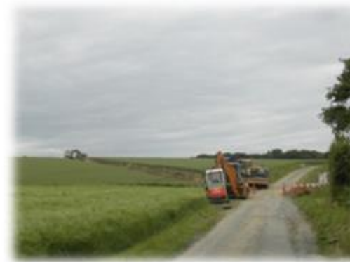
▲ Photo n° 1 : Travaux à la pelleuse.
