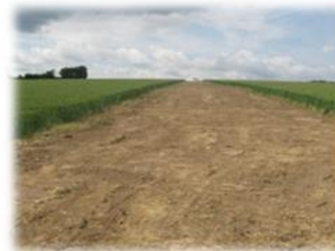
▲ Photo n° 3 : Remise en état de la terre végétale.
