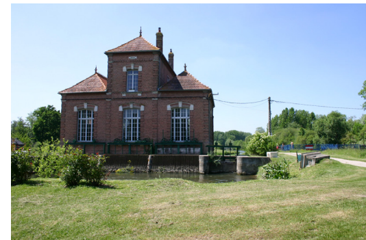
Fig.128. Usine hydroélectrique de Long
