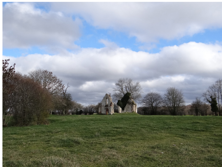
Fig. 90. Chapelle des Templiers. Perception immédiate depuis la RD29. Vue vers l'Est.
