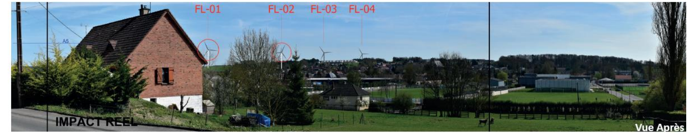
Figure 82 : PM107, Depuis le portail du château de Flixecourt à Flixecourt
