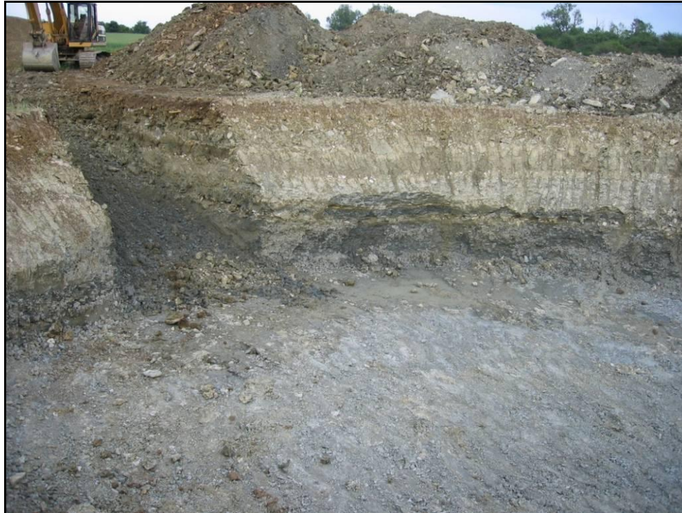
Figure 63 : Photo de fond de fouille
