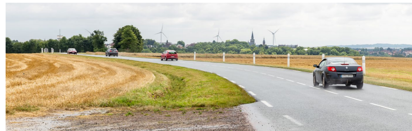
Photographie 55. Les clochers de Montdidier et le contexte éolien proche
