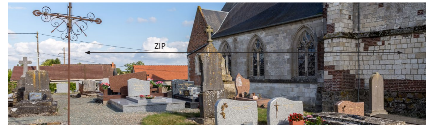
Photographie 50. Vue depuis les abords de l'église de Rocquencourt
