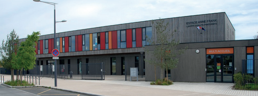
ÉcoQuartier du Hameau, Saint-Jean-de-Braye, Centre-Val de Loire, Étape 3, 2016
