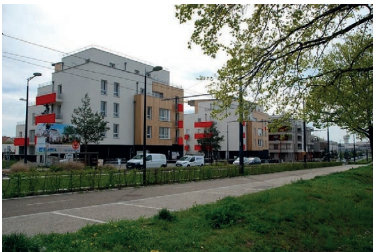
ÉcoQuartier du Hameau, Saint-Jean-de-Braye, Centre-Val de Loire, Étape 3, 2016
