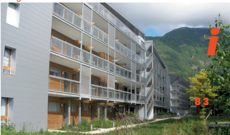
Blanche-Monier, Grenoble, Auvergne-Rhône-Alpes, Étape 3, 2014 # Logements communaux réservés
