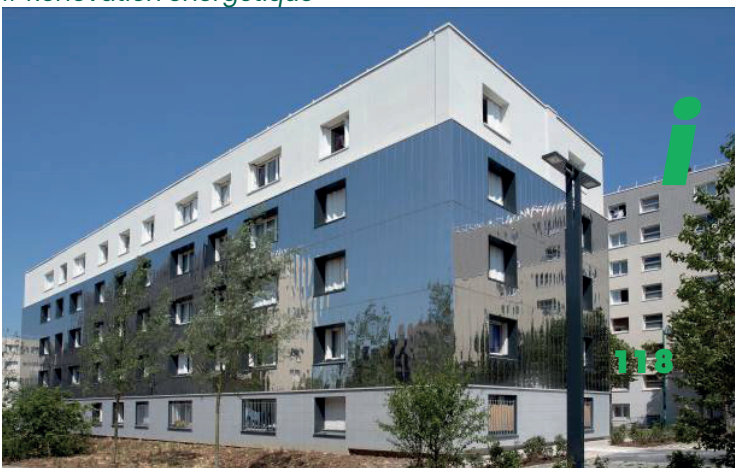
Quartier du Val Fourré, Mantes-La-Jolie, Île-de-France, Étape 3, 2015 # Rénovation énergétique
