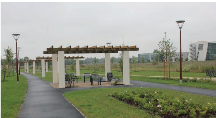
Quartier de l'Eau Vive tranche 1, Lieusaint, Île-de-France, Étape 3, 2017 # Stockage sur espace public
