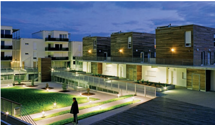
ÉcoQuartier de Monconseil, Tours, Centre-Val-de-Loire, Étape 3, 2014
