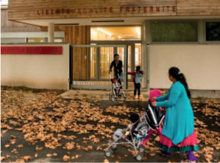
Projet de rénovation urbaine Derrière-les-Murs-de-Monseigneur-Cerisaie, Villiers-le-Bel, Île-de-France, Étape 3, 2017
