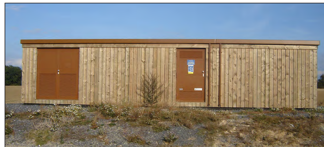
Figure 165 : Poste de livraison type
