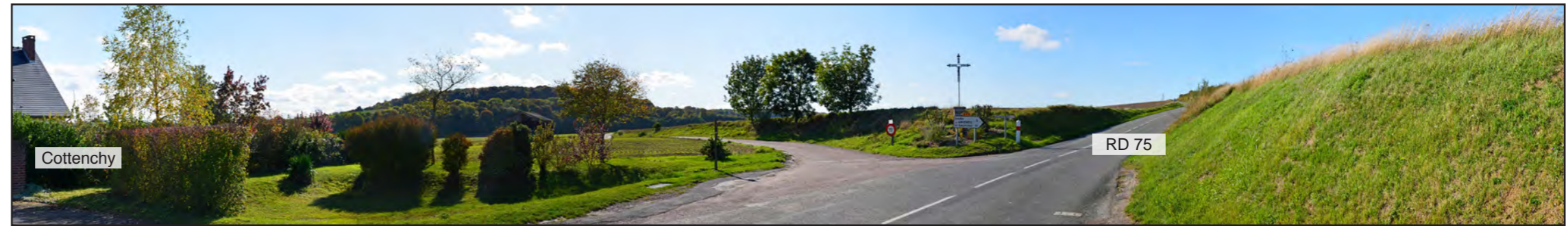
État initial - Vue panoramique
