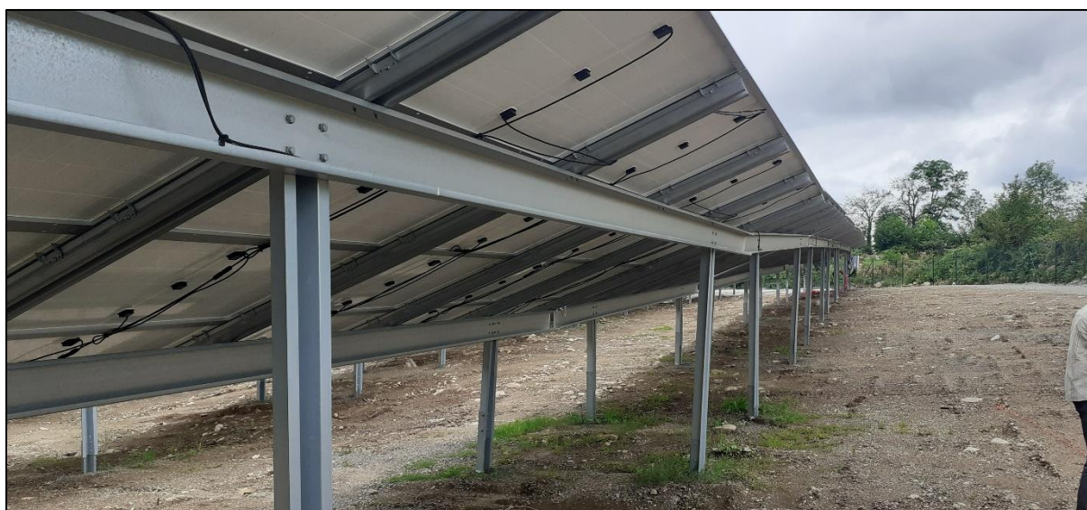
Figure 2. Exemple de fondation en pieux battus (source : GreenYellow)
