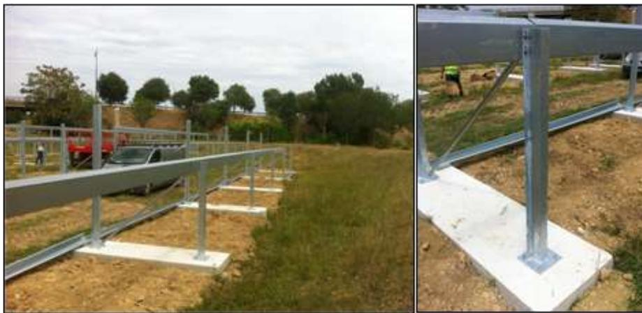
Figure 75 : Systèmes de pieds lestés par du béton (longrine en béton).
