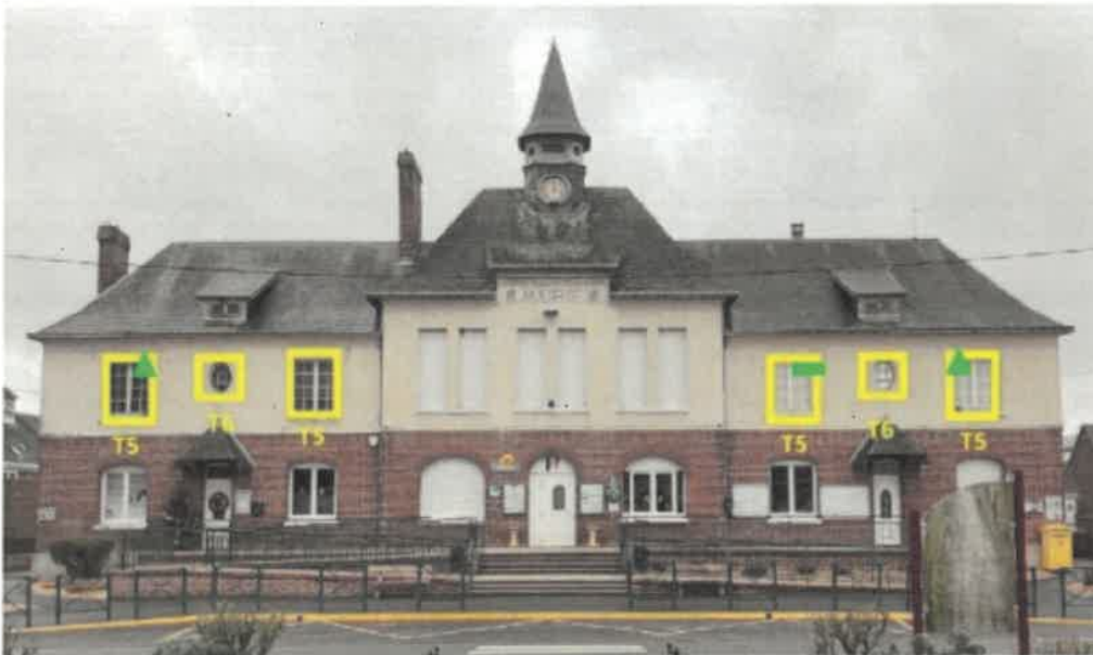
Photo de la façade Est – Façade principale depuis la rue de l’Eglise
