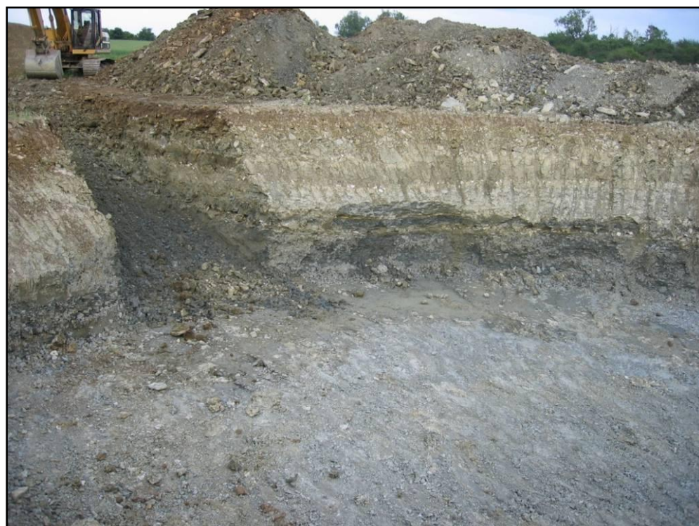
Figure 27 : Photo de fond de fouille
