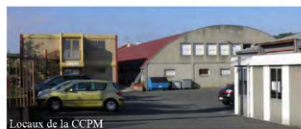
Locaux de la CCPM
