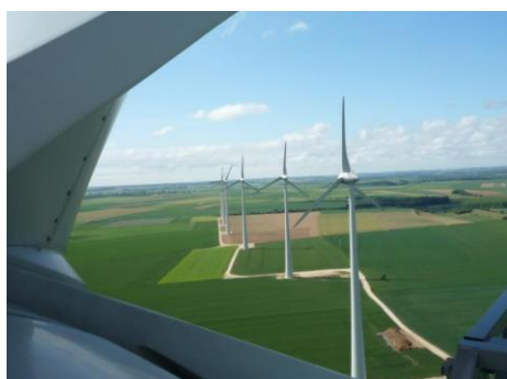
Parc éolien du Nouvion 1
